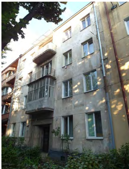
Kamienica we Lwowie przy ul. Potockiego 76
