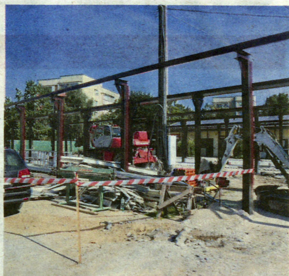
Fot. Trwają przygotowania pod nowy, zadany plac targowy.
