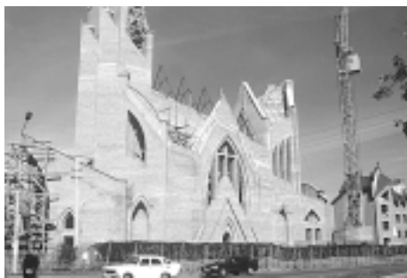
Nowy kościół rzymskokatolicki w Tarnopolu, w budowie
