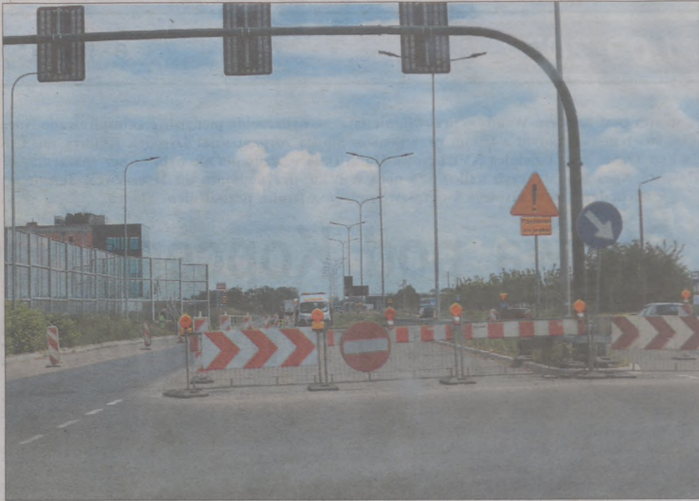
Na rozbudowę ulicy Igołomskiej, jeszcze w tym roku trafi z rządowego programu 25,6 mln zł, co na pewno pozwoli na dokończenie tej oczekiwanej inwestycji infrastrukturalnej.
