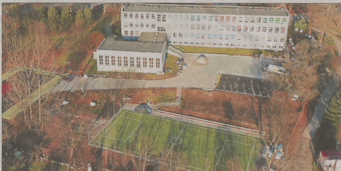
Budowa boisk i siłowni zewnętrznej przy SP nr 129 w os. Na Stoku. Fot. Grawit Nosiadek
