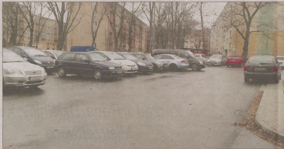
Wyremontowane miejsca postojowe w osiedlu Albertyńskim 24 i 29.
