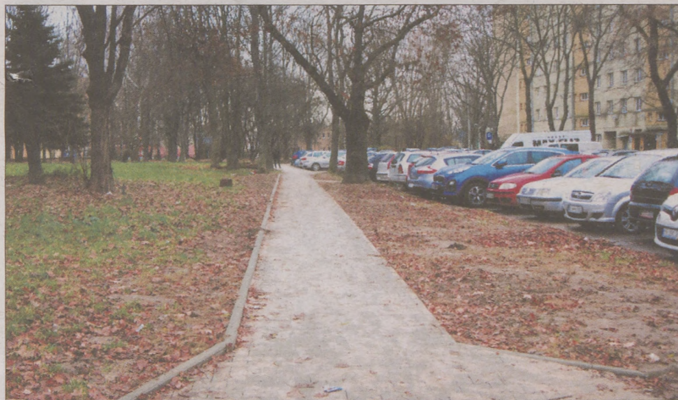
Wyremontowany chodnik w os. Kazimierzowskim, pomiędzy blokami 18 i 27.
