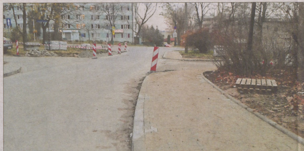
Remont ulicy Królowej Bony w osiedlu Jagiellońskim w okolicach bloku nr 21.
