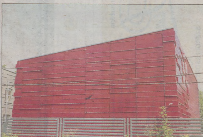
Trzeci budynek magazynu ocalał, ale jeszcze nie jest gotowy do użytkowania.
