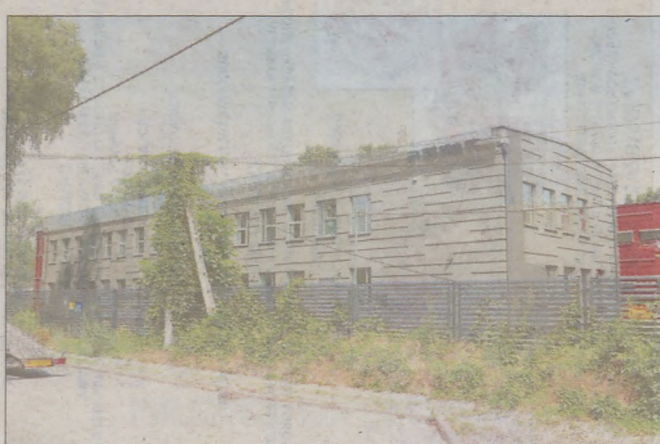
Główny budynek wymaga doprowadzenia prądu i gazu i stworzenie odpowiednich warunków dla dalszych prac archiwistów.
