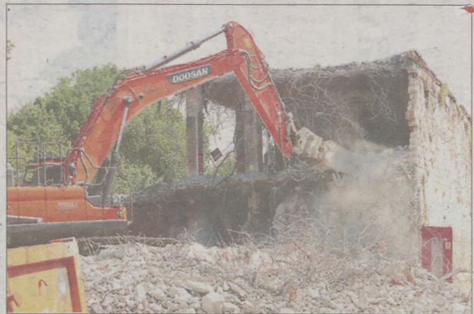
Trwa rozbiórka spalonych magazynów.
