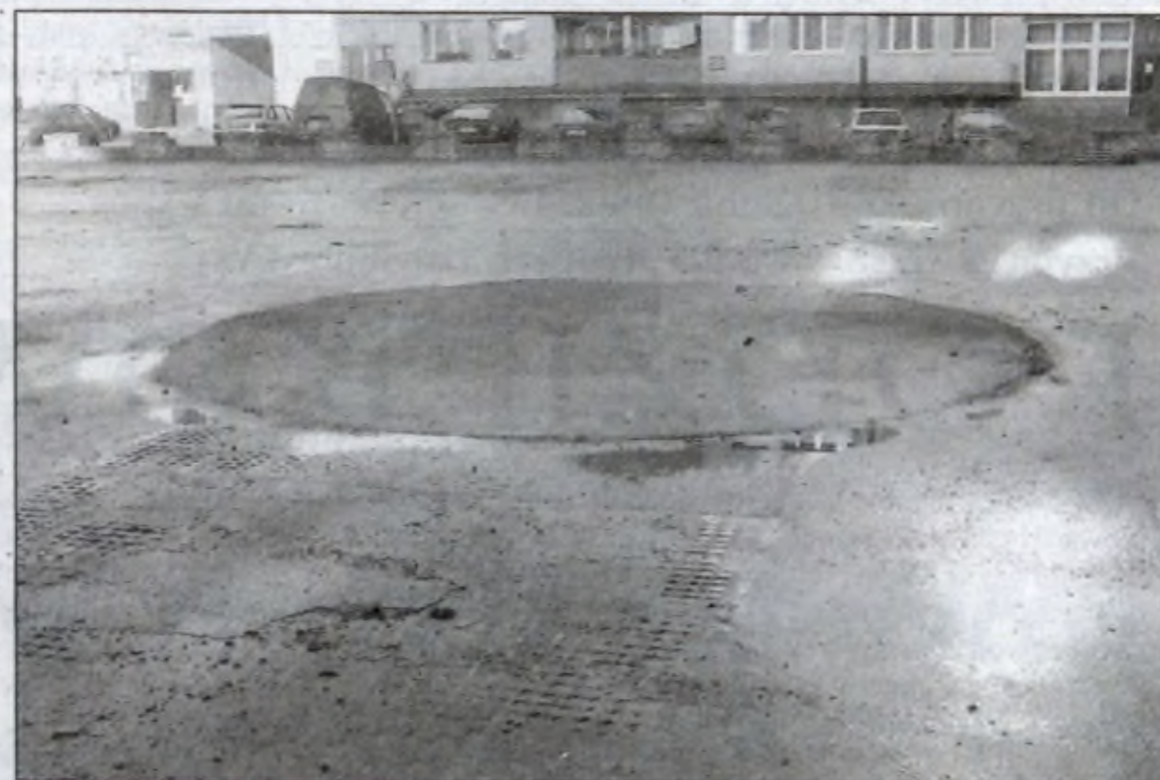
Z asfaltu wycięto już urządzenia zabawowe.
