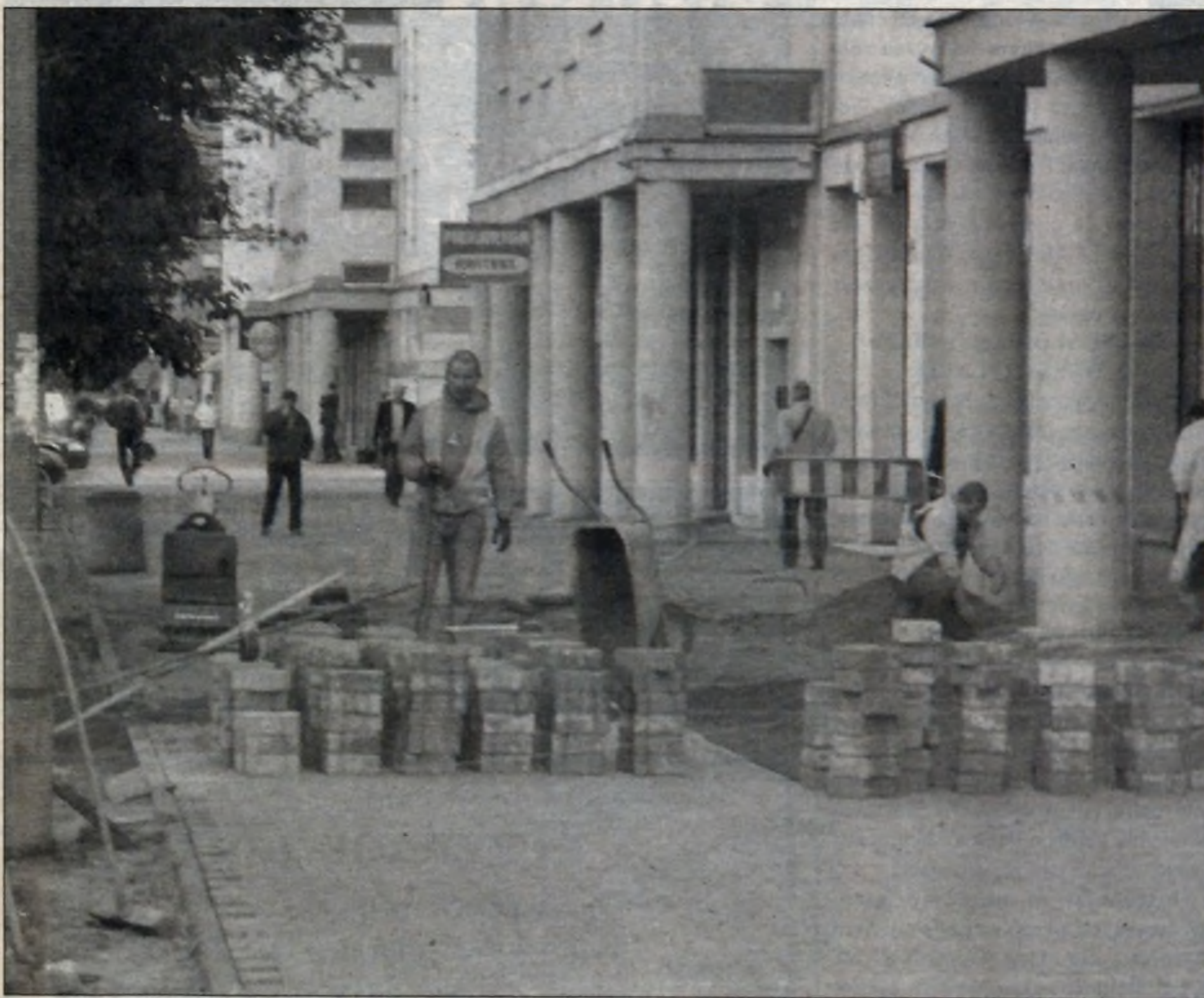
Remont chodnika przy al. Solidarności na wysokości os. Hutniczego.
