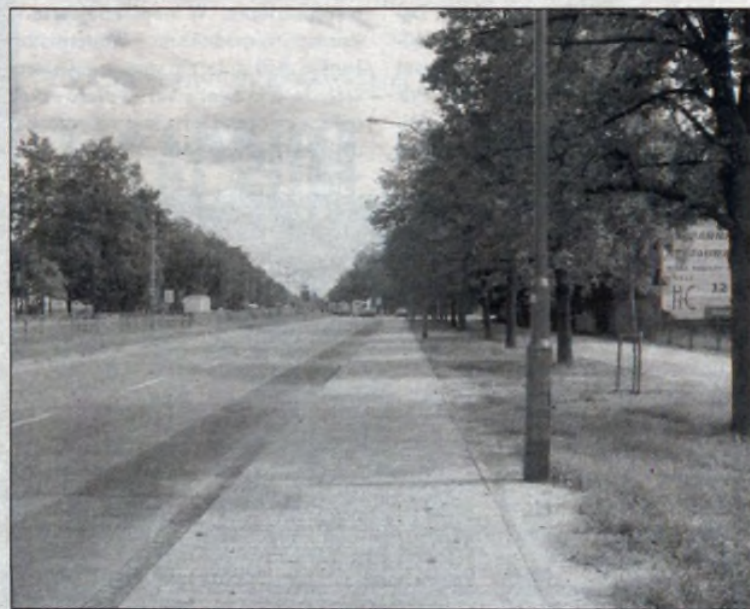
Wyremontowane pobocze al. Jana Pawła II od strony południowej na wysokości os. Centrum E.
