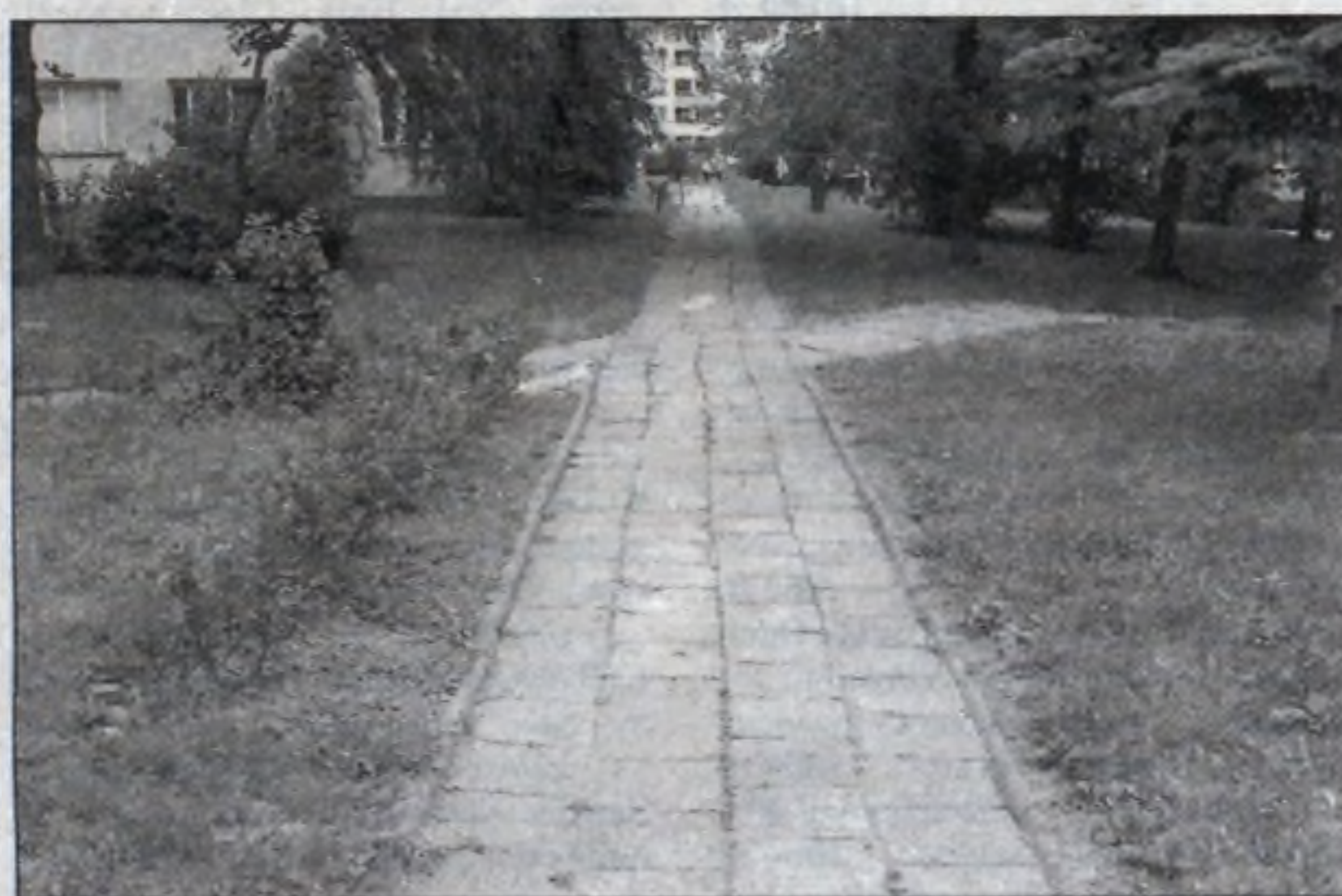
Tak wyglądał do niedawna remontowany obecnie chodnik.
