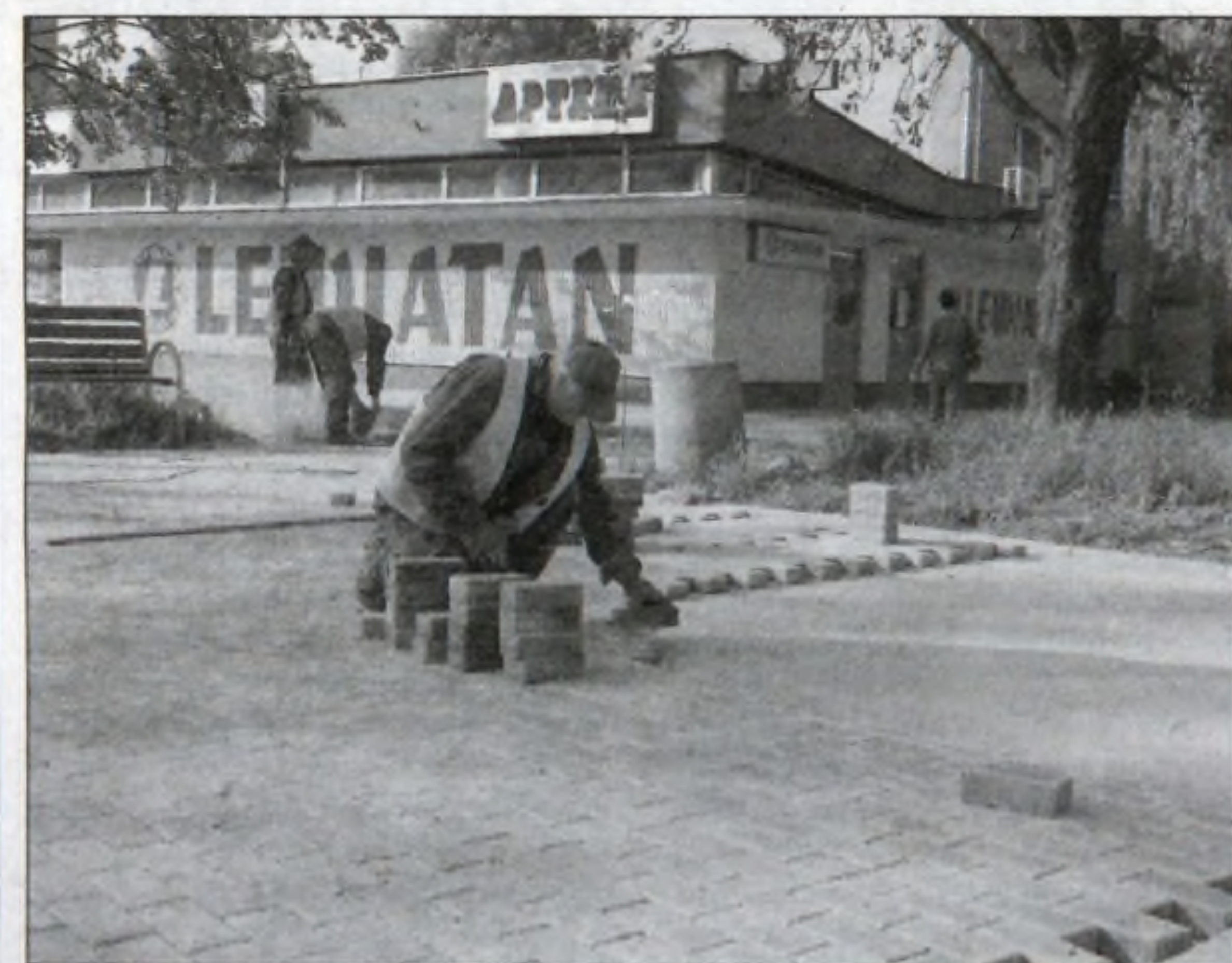
Przy ulicy Lawendowej powstaje nowy chodnik. Budowane są także nowe miejsca postojowe.
