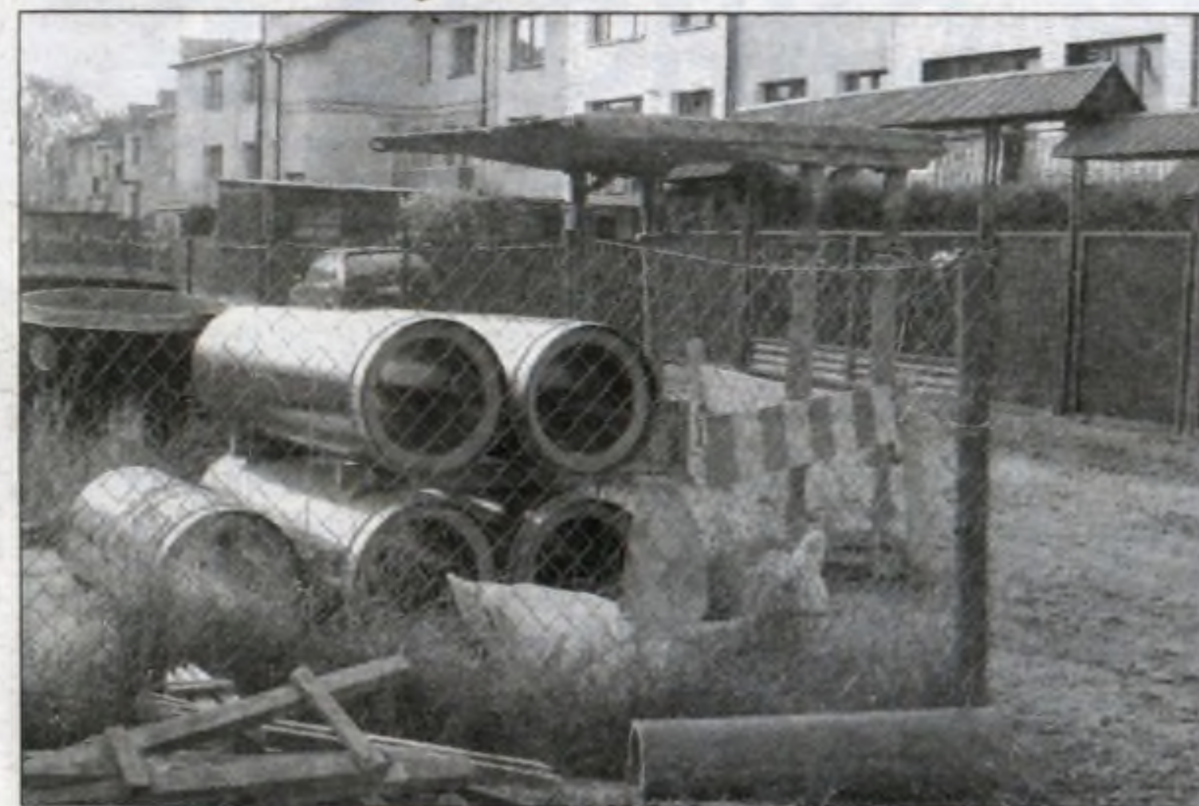
Trwają prace przy przebudowie ulicy Kaczeńcowej bocznej.
