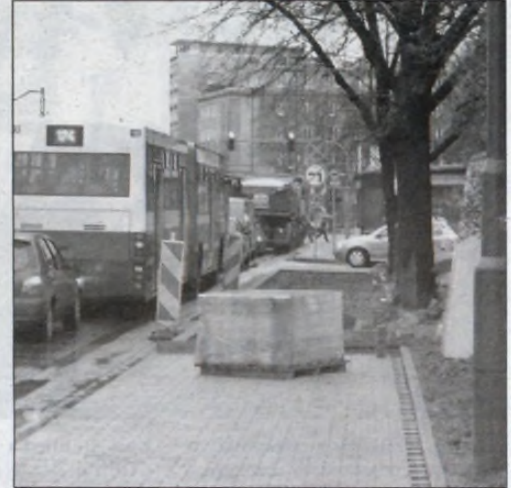
Na wysokości os. Centrum A do zakończenia budowy pozostało już niewiele pracy.
