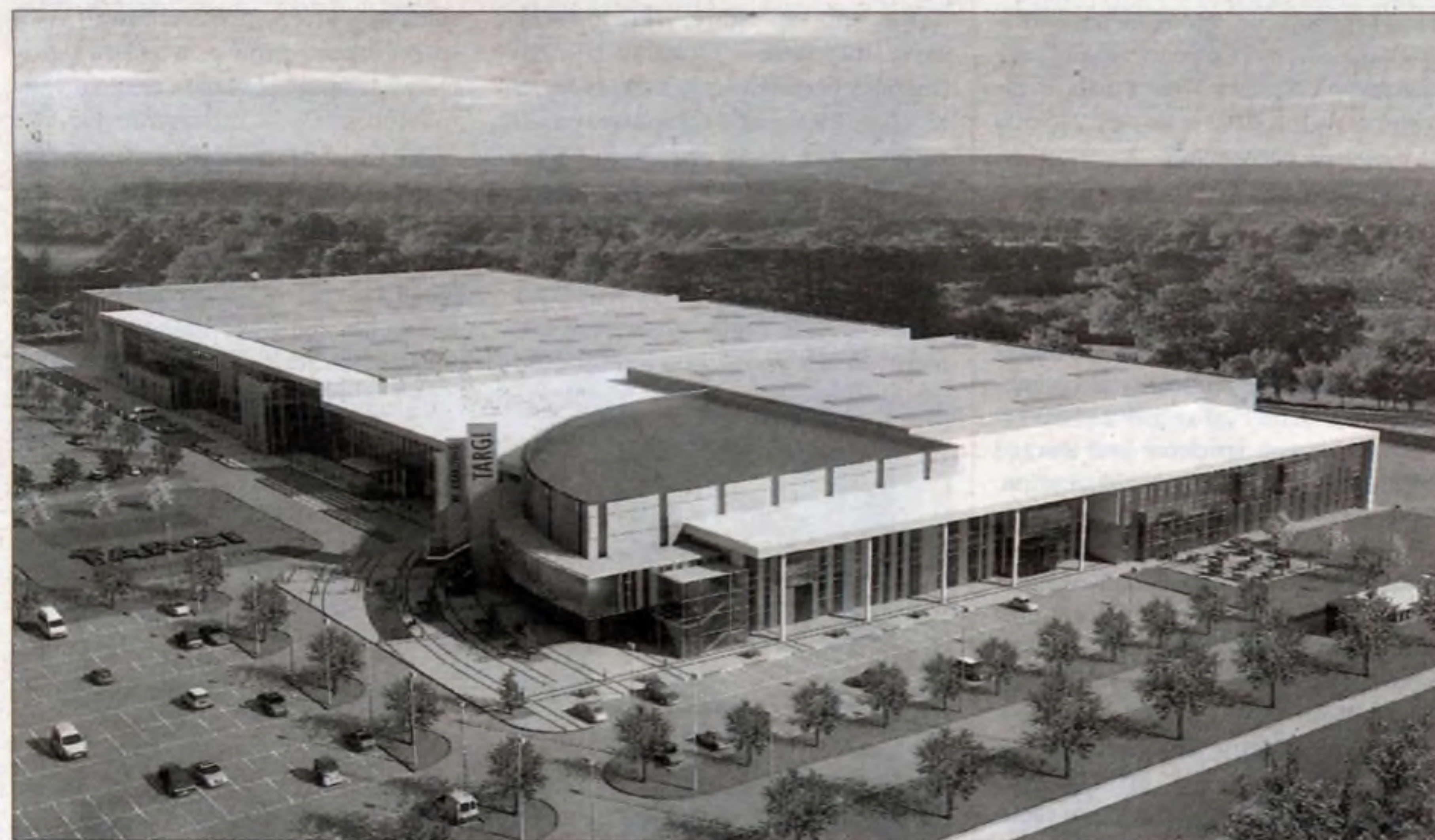
Budowa Centrum Targowo-Kongresowego CRACOVIA EXPO pozwoli na rewitalizację zdegradowanych terenów po byłych zakładach „Prefabet” przy ulicy Centralnej.
