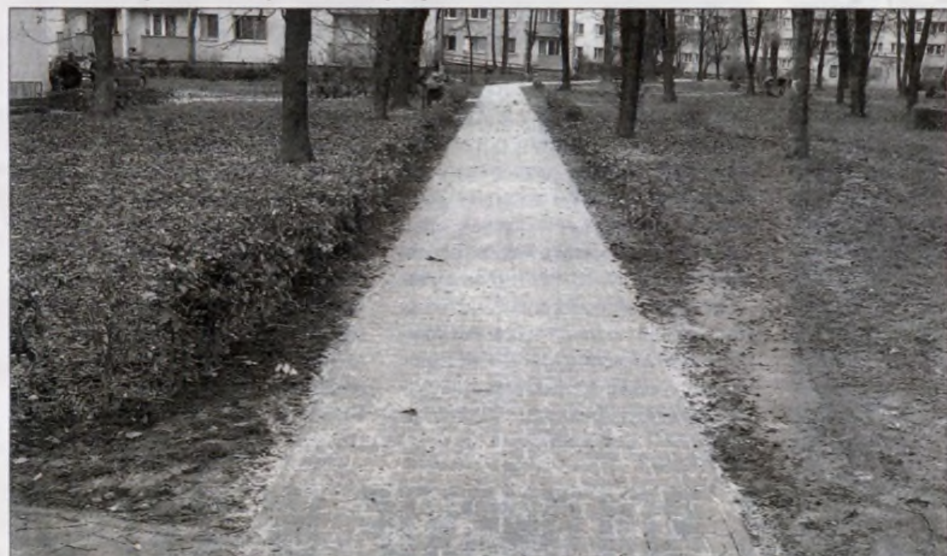
W tym miejscu osiedla Albertyńskiego, gdzie wcześniej modernizowano sieć ciepłowniczą, powstał nowy chodnik. Fot. Stanisław Bury.
