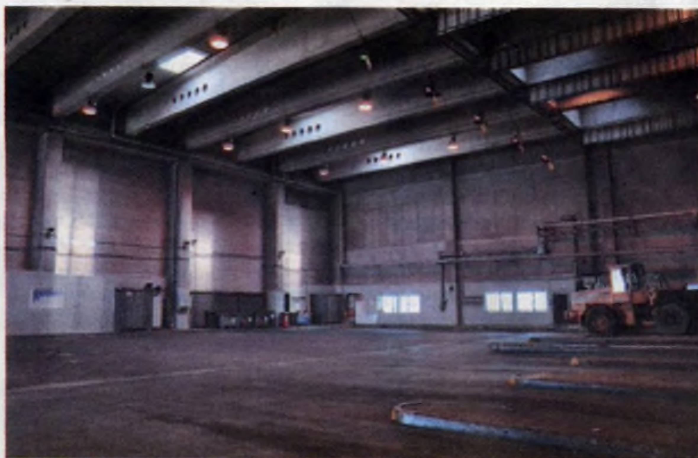
Spalarnia w Hamburgu – hala przyjęcia odpadów.
