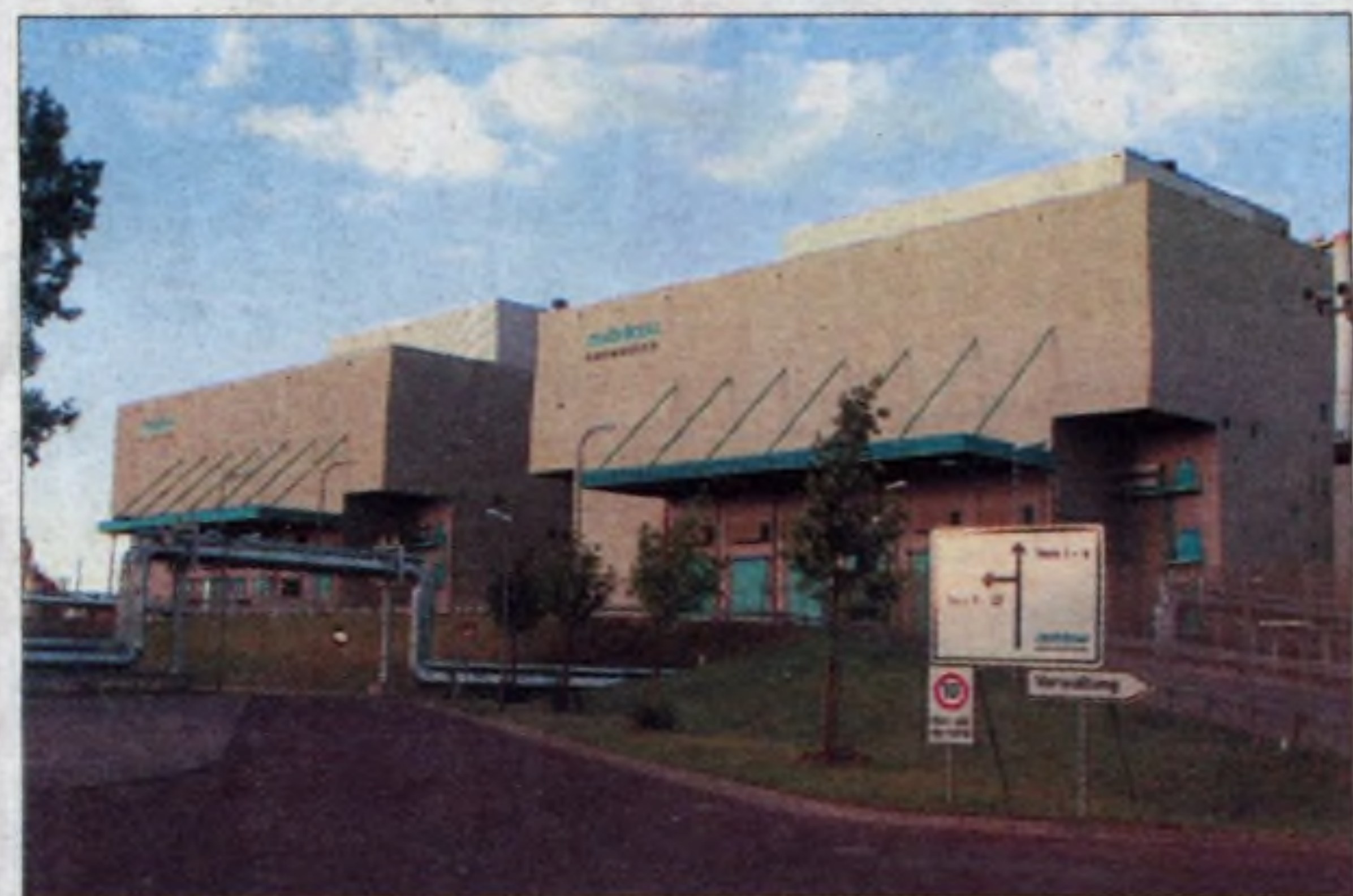
Spalarnia odpadów komunalnych MHKW Rhotensee w Magdeburgu.
