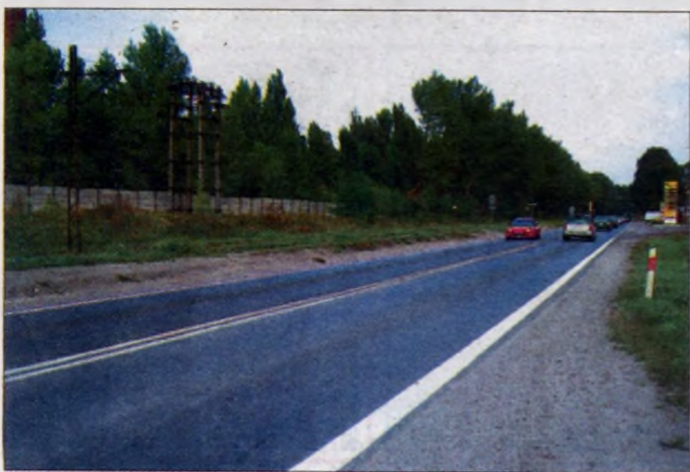
Ul. Igołomska, niedawno pełna dziur, teraz jest gładka. Ale to dopiero początek modernizacji tej ruchliwej arterii prowadzącej do Nowej Huty.
