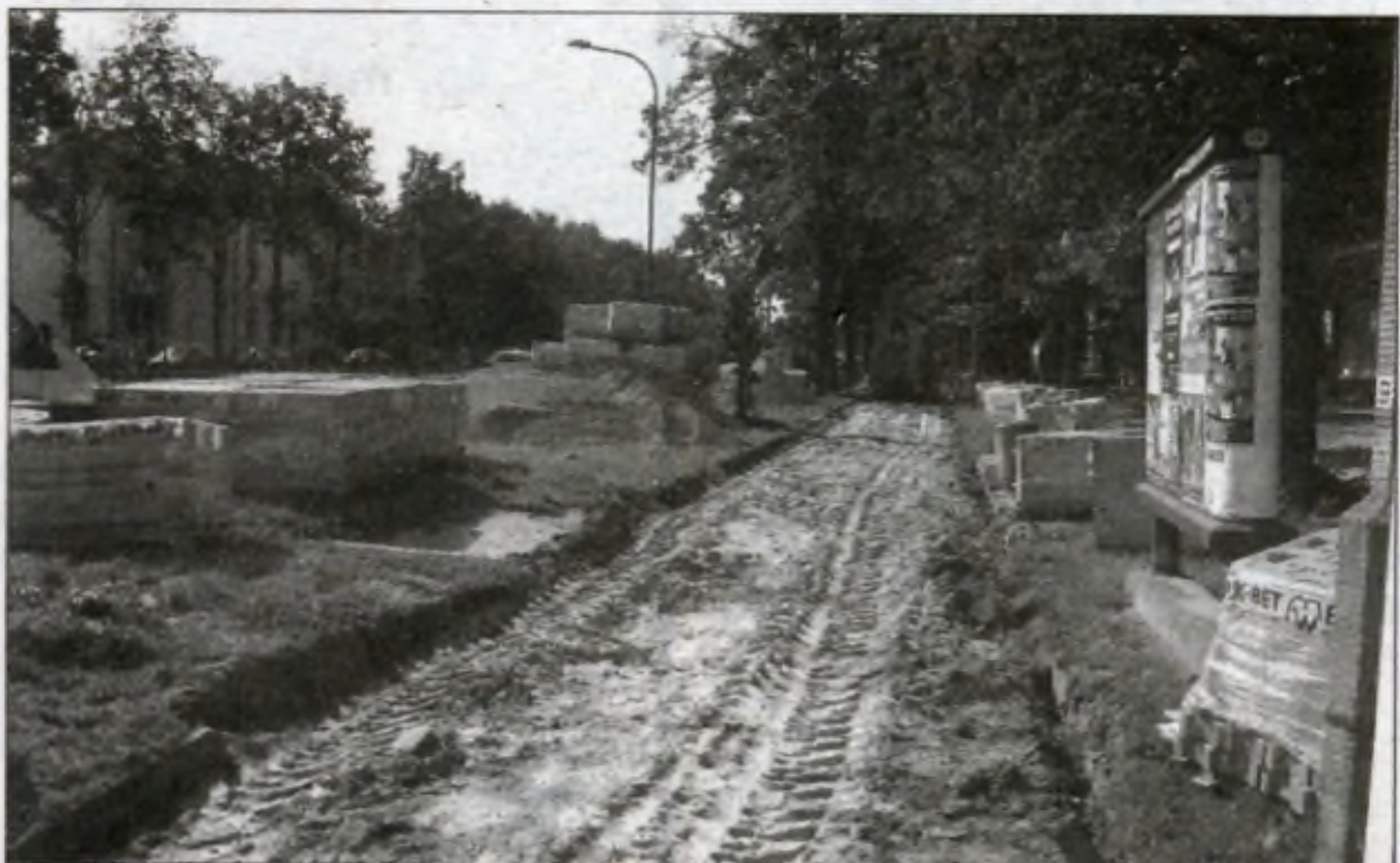
Trwa przebudowa chodnika od strony os. Ogrodowego.
