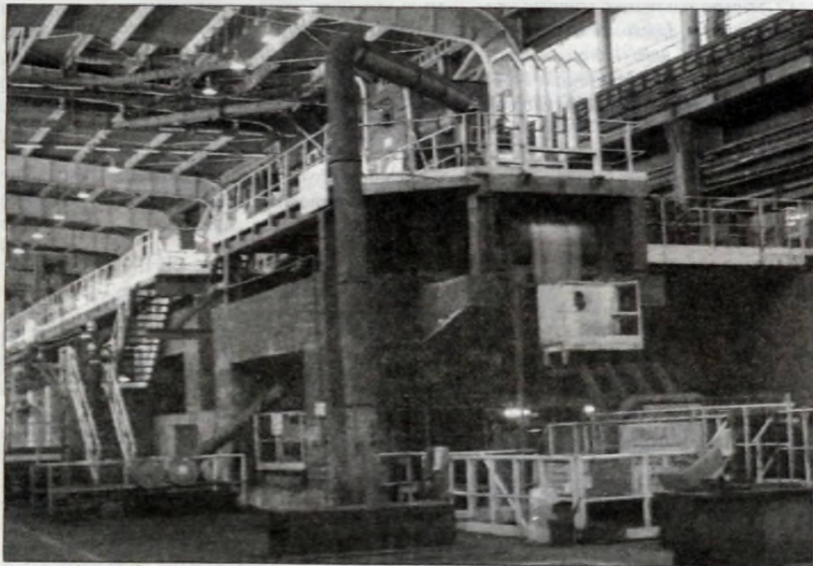
Już niedługo w miejscu starej prostownicy naciągowej stanie nowa, wyposażona w układ odprowadzania zgorzeliny. Dzięki temu możliwe będzie bardziej skuteczne wstępne rozbieżenie zgorzeliny.
