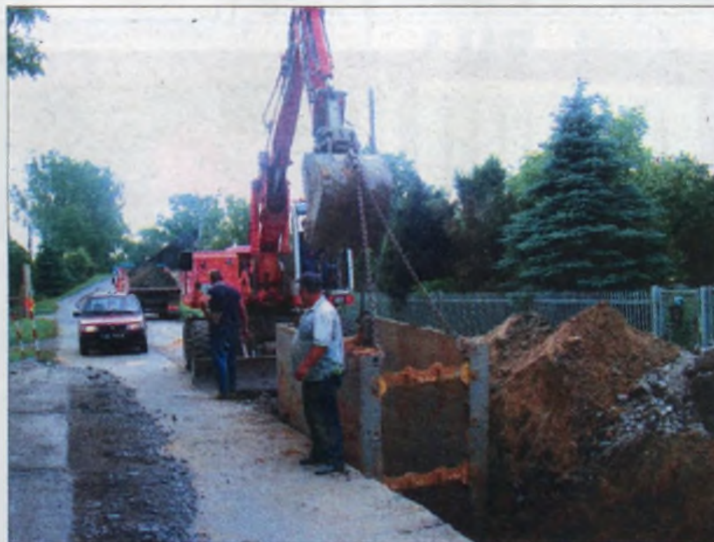
Prace w Branicach są prowadzone sprawnie, bez wstrzymywania ruchu drogowego.
