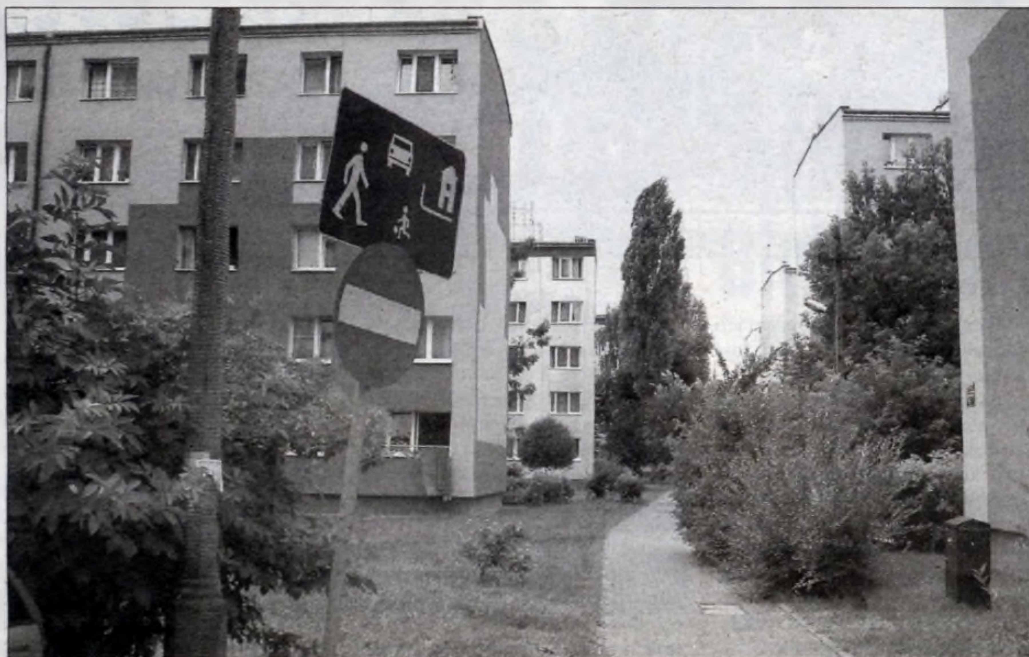
W nowohuckiej aglomeracji znaczna część mieszkańców mieszka w zasobach spółdzielni mieszkaniowych. Na zdjęciu: bloki SM Bieńczyce są zadbane po zrealizowaniu programu termomodernizacyjnego i są objęte pełnym monitoringiem.
