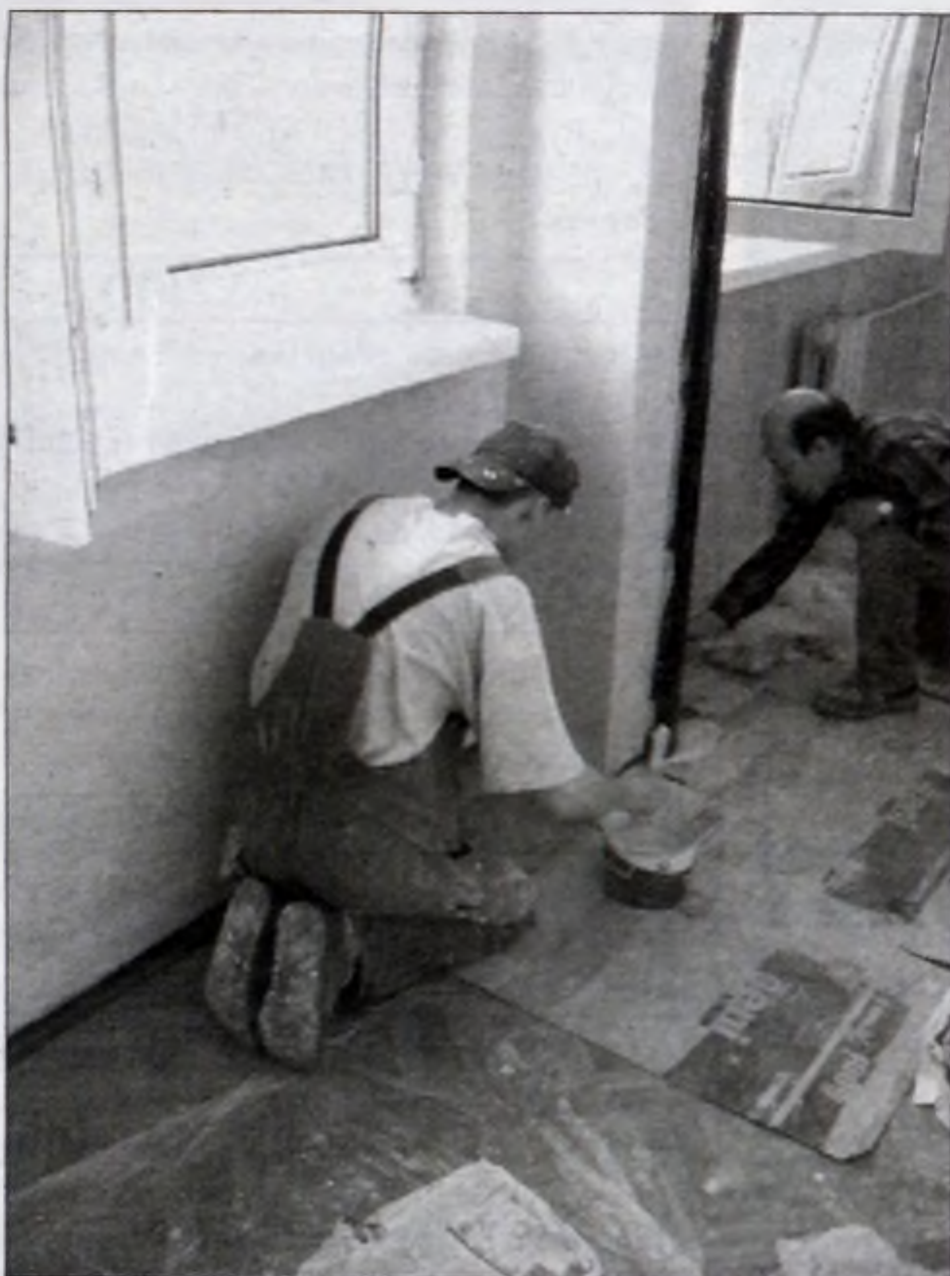
Bezrobotni zatrudnieni prac społecznie użytecznych remontują siedzibę KIS. Zamieniają się w zdyscyplinowanych fachowców.
