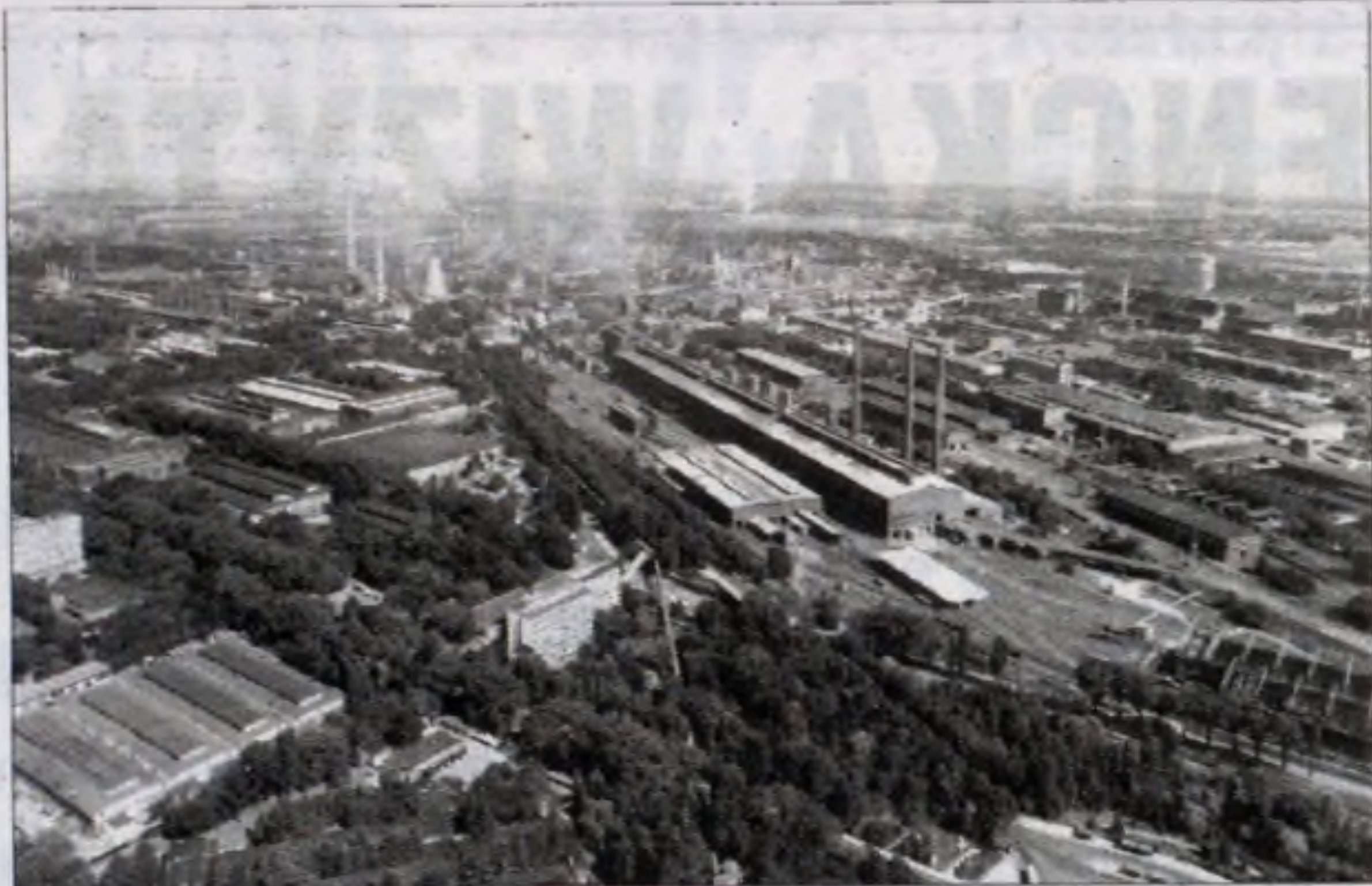
Ten największy budynek to właśnie stalownia martenowska. Po jej wyburzeniu i zburzeniu pozostałych budynków krakowska huta „odzyska” 26 hektarów terenu.
