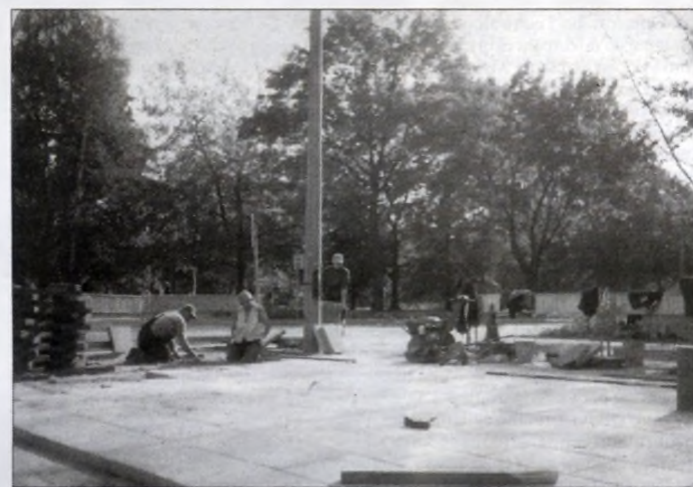
Ostatnie prace porządkowe w os. Zgody.
