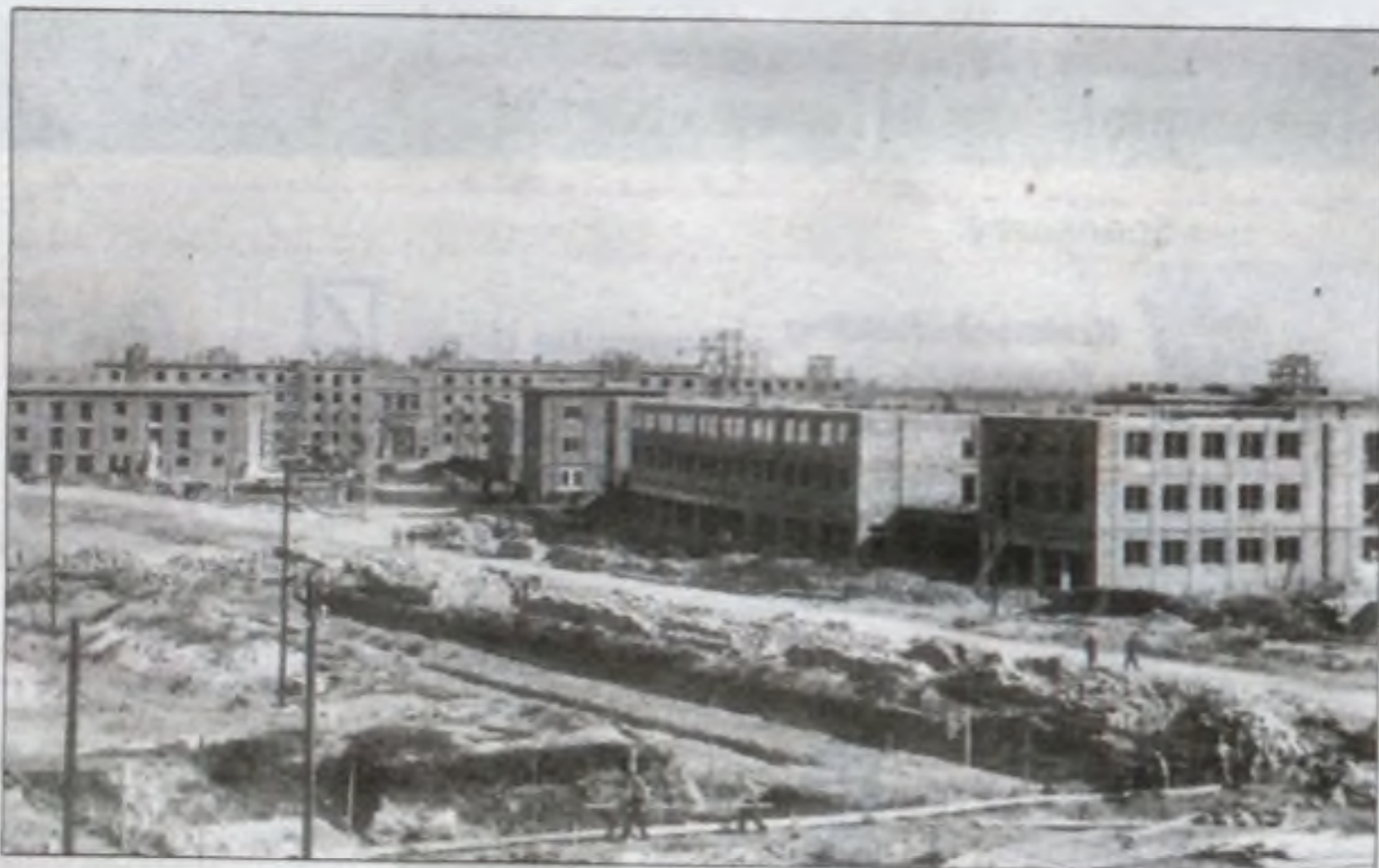
Budowa Osiedla C-1 (Teatralne), 1952 r.
