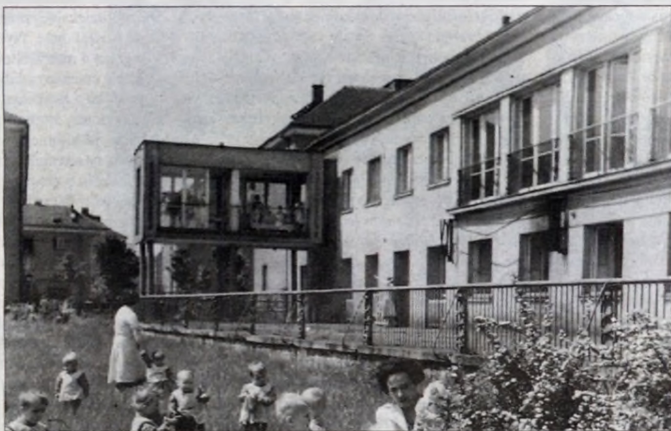
Żłobek na osiedlu A-1 Północ (Willowe), koniec lat 50. XX w. Fot. Henryk Hermanowicz, wł. MHK
