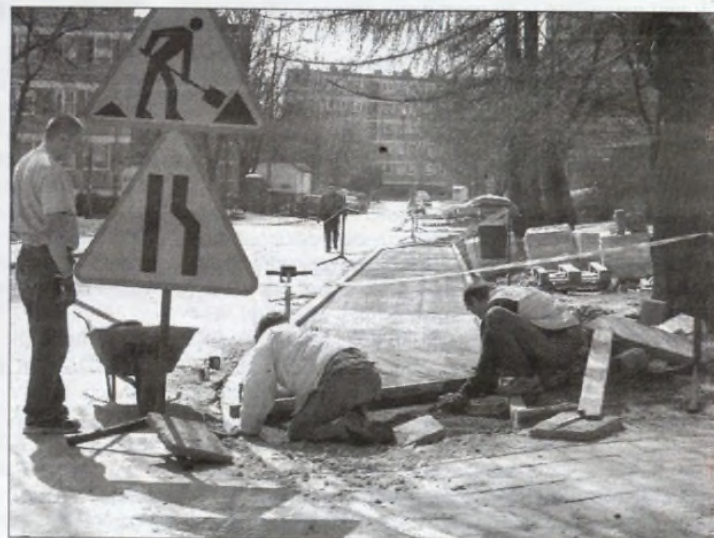
Remonta chodnika przy ul. Świdnickiej os. Tysiąclecia.
