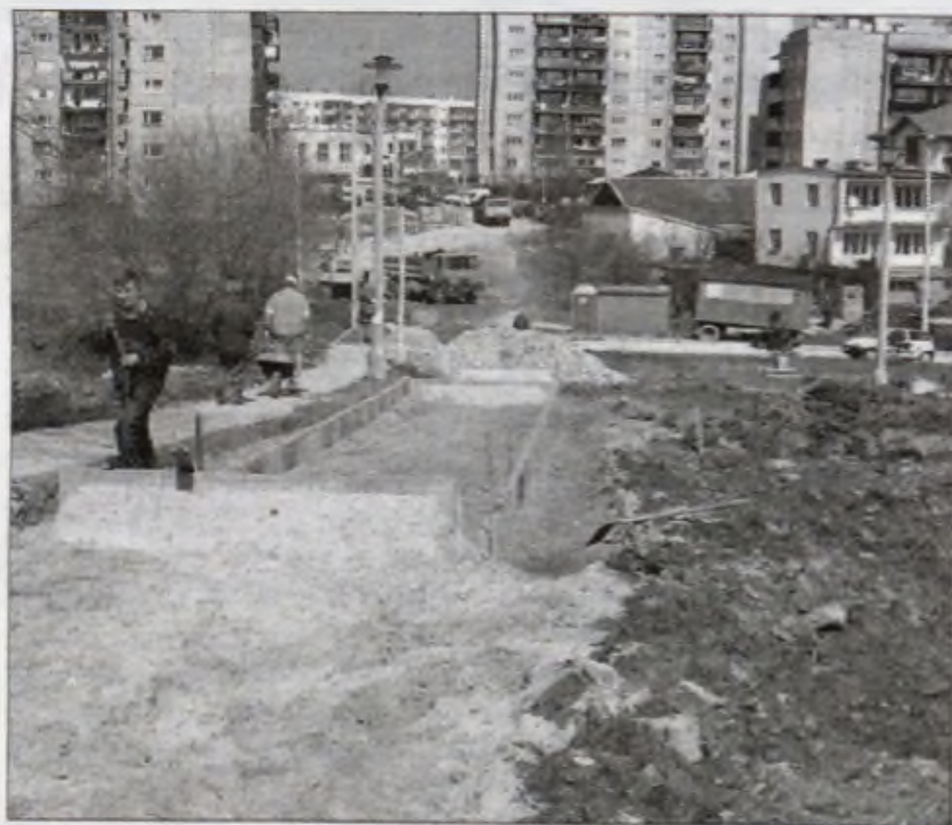
Budowa połączenia ul. Sapiechy z ul. Korfańskiego oraz chodnika ze schodami do ul. gen. Okulickiego.
