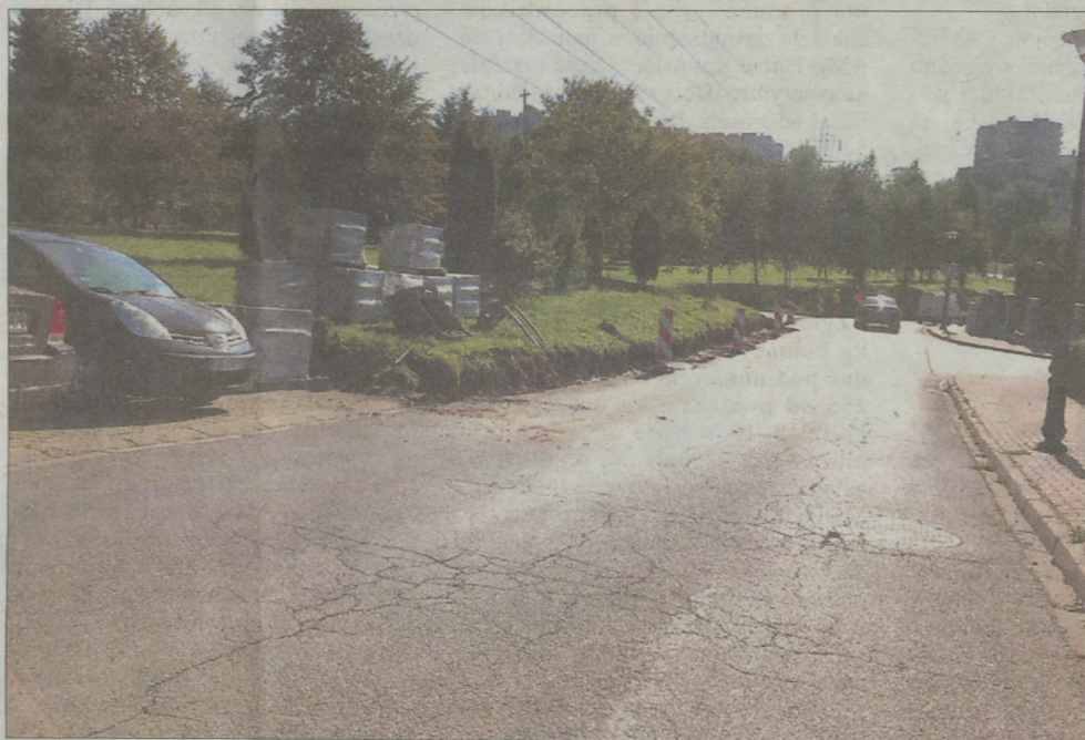
Rozpoczęła się modernizacja ulicy Parnickiego – wymiana nawierzchni jezdni oraz remont chodnika i miejsc postojowych.
