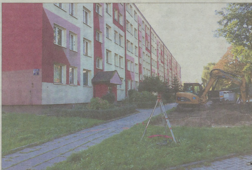
Nowe miejsca postojowe oraz remont już istniejących przed blokiem nr 24 i 28 na os. Piastów.
