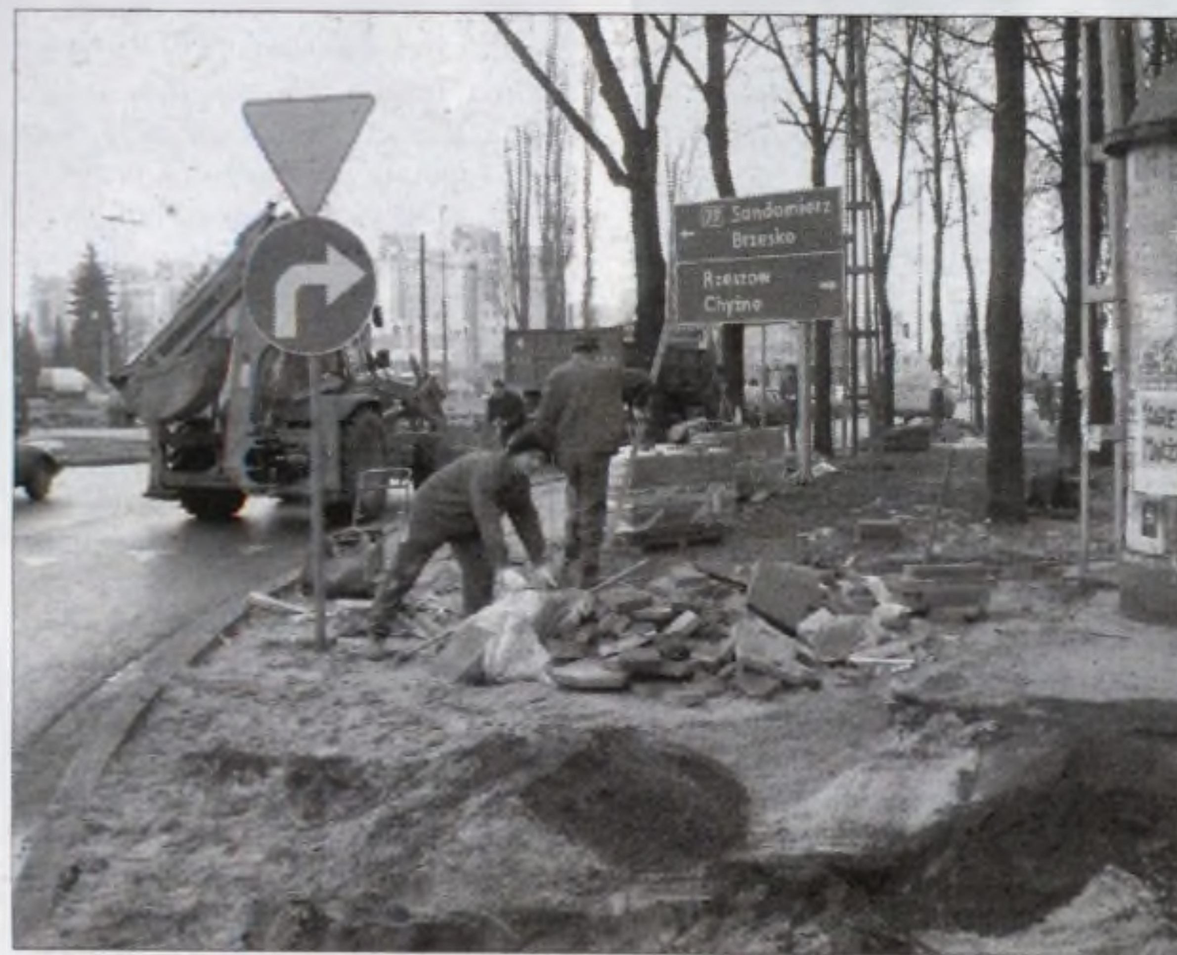
Wymiana płytek chodnikowych wokół pl. Centralnego, od strony jezdni, to uzupełnienie prac z poprzedniego remontu, gdy płytki wymieniono tylko w górnej części placu przy ścianach budynków.
