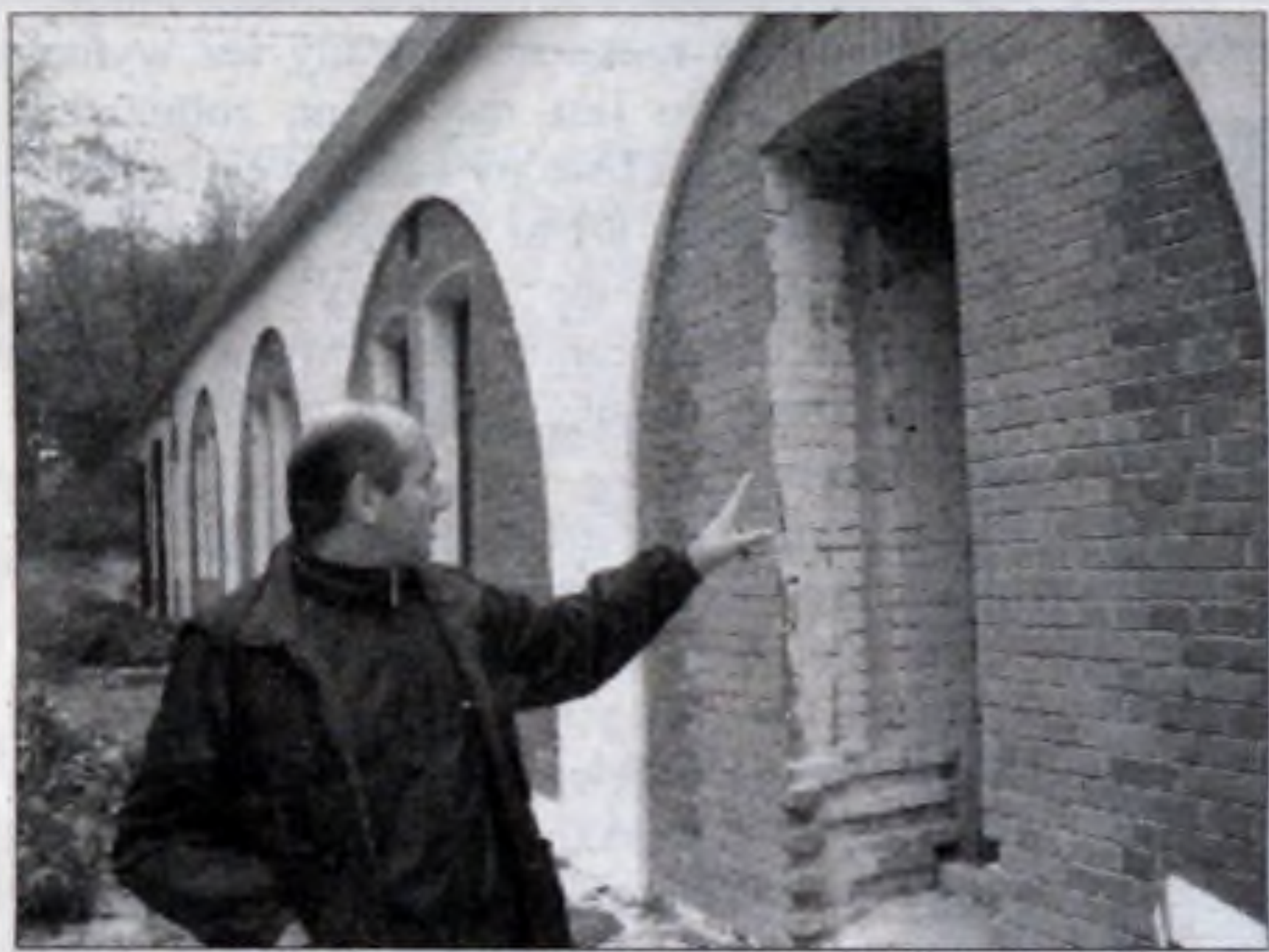
Prace remontowe przy adaptacji lewej strony koszar szyjowych zostały zakończone. Trwa adaptacja pomieszczeń.
