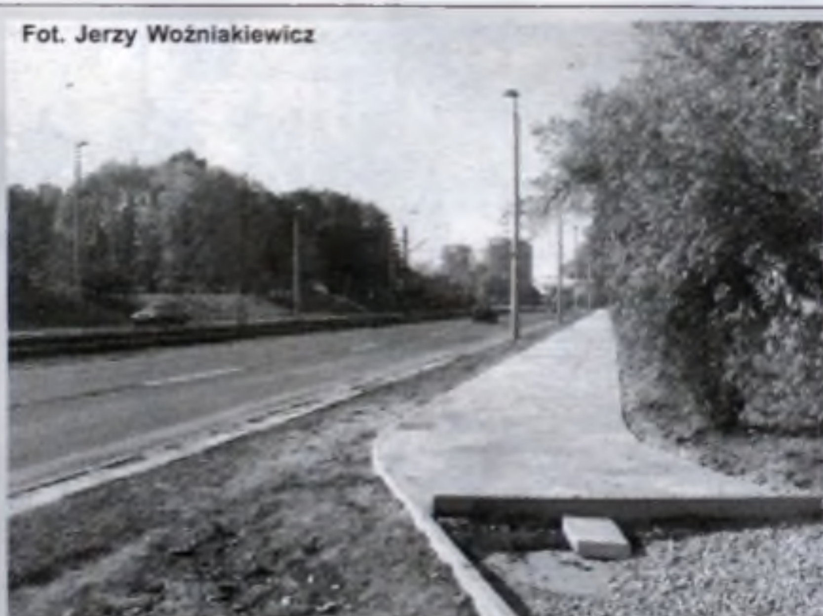
Fot. Jerzy Woźniakiewicz Już niedługo podróż rowerem ze Śródmieścia do Nowej Huty będzie znacznie bezpieczniejsza i przyjemniejsza. Dzielnica XIV prętnie bowiem ścieżka rowerowa wiodąca wzdłuż al. Jana Pawła II. Jej budowa właśnie się rozpoczęła.
