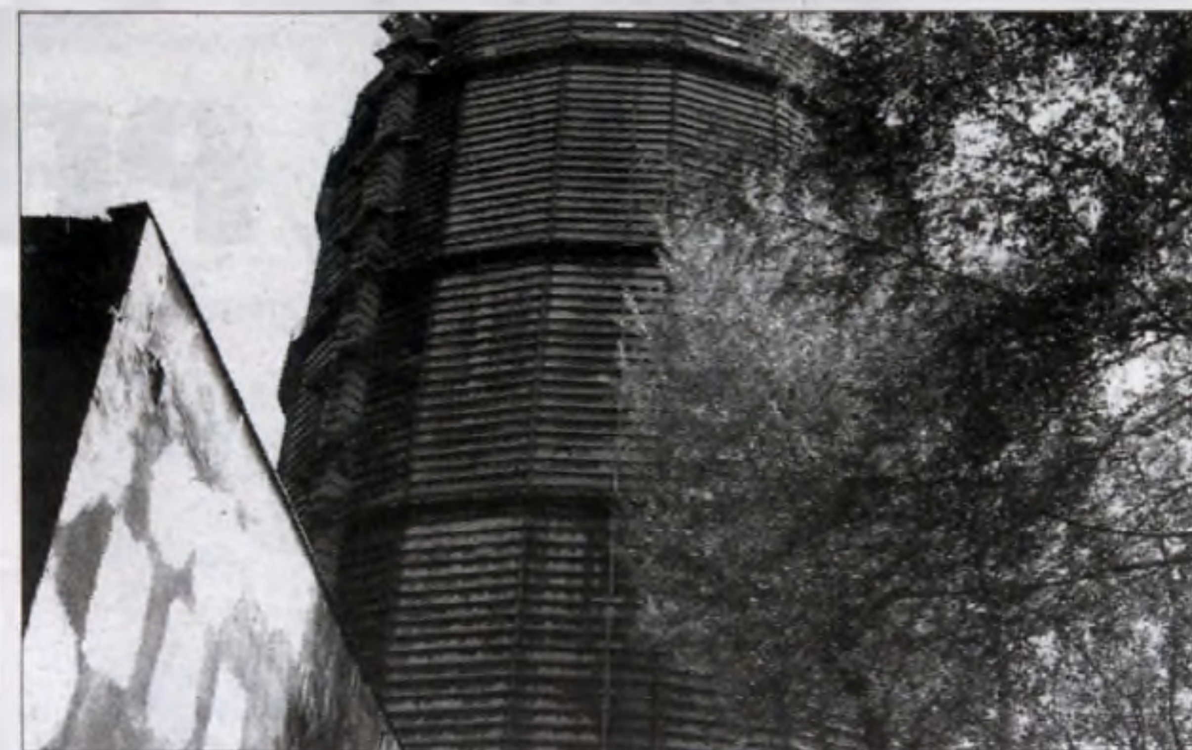
Te olbrzymie metalowe zbiorniki to już historia...
