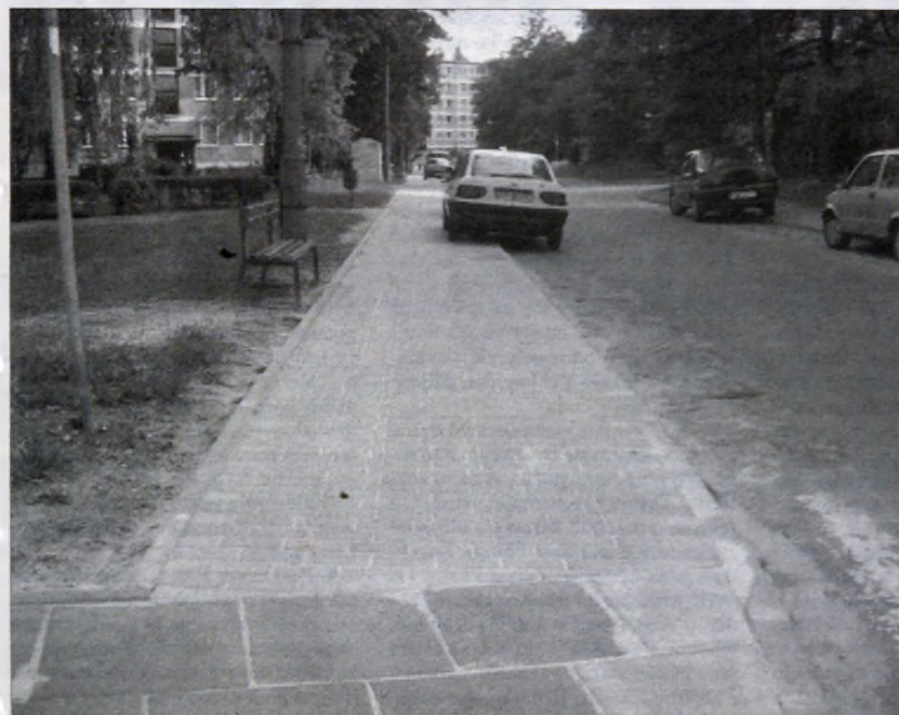
Nowy chodnik przy ul. Świdnickiej.
