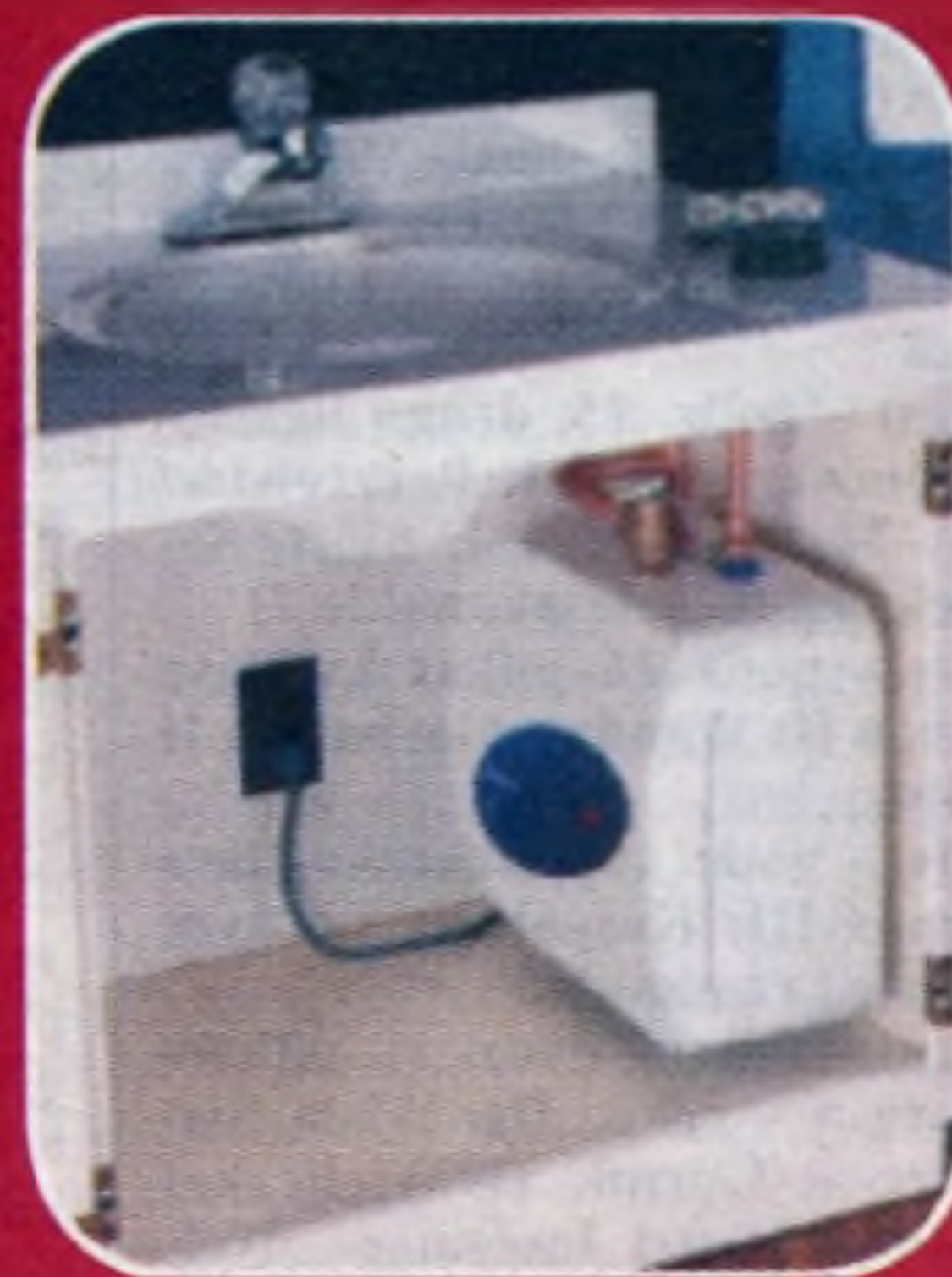
Rys. 3 – Mały podgrzewacz elektryczny TIShape zainstalowany pod zlewem
