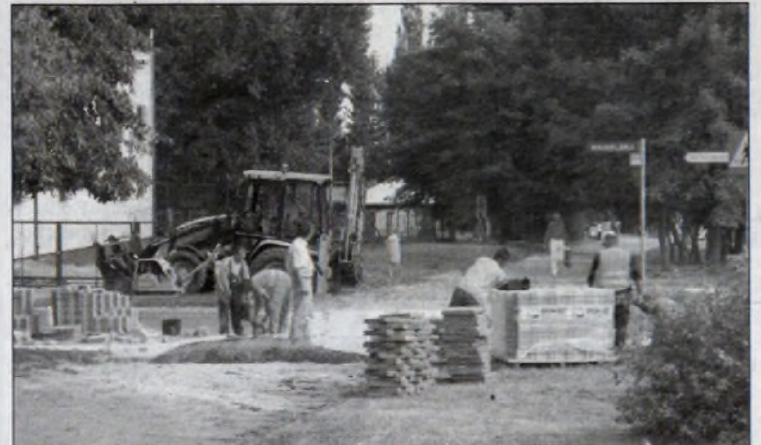
Remont chodnika przy ul. Wawelskiej.
