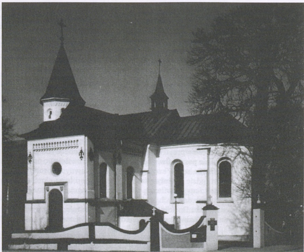
42. Kościół Narodzenia NMP w Bieżanowie od strony południowej.
