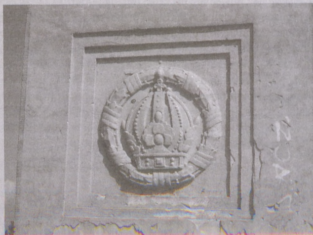
Tarcza herbowa umieszczona na ścianie frontowej pomnika „Odparcia Rosjan”
