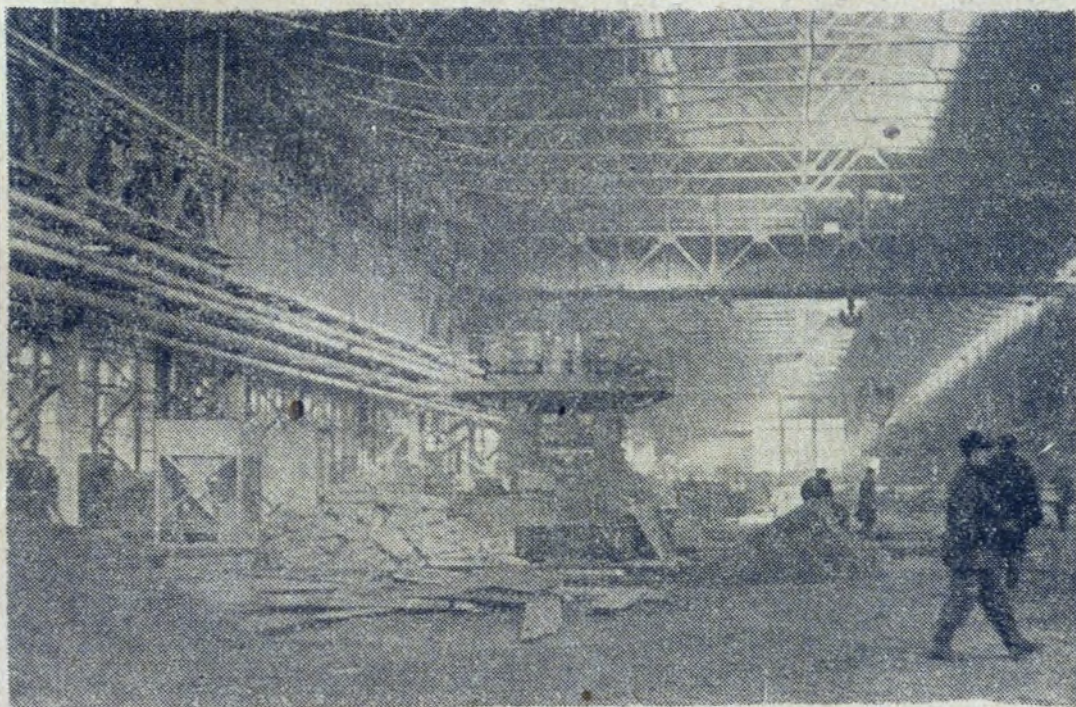
Widok ogólny hali Walcowni Zimnej — prace przy instalowaniu urządzeń.
