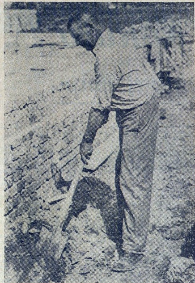
Andrzej Piwowarczyk osobiście zasypuje fundamenty domku, budowanego wspólnie z Antonim Walczakiem .
