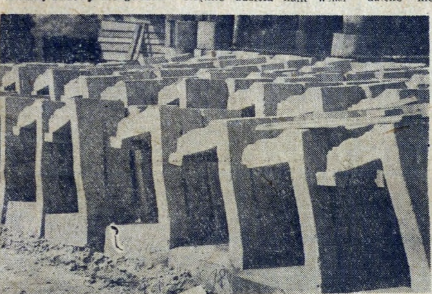
Na odcinku bankowców suszą się dziesiątki prefabrykatów budowlanych.
