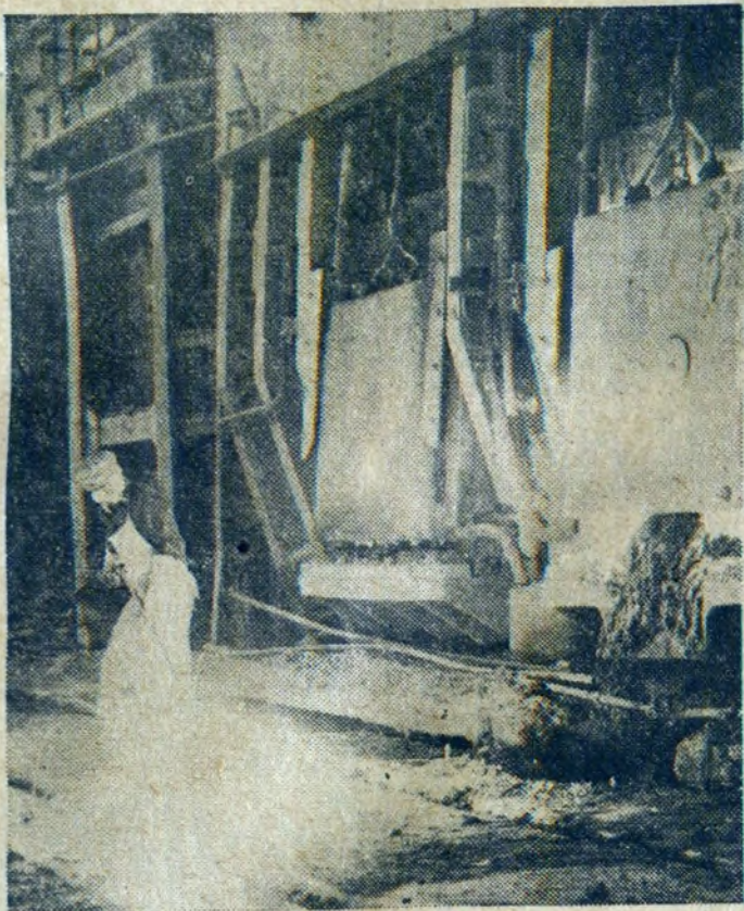
Stalownia — pobieranie próbki stali do analizy.
