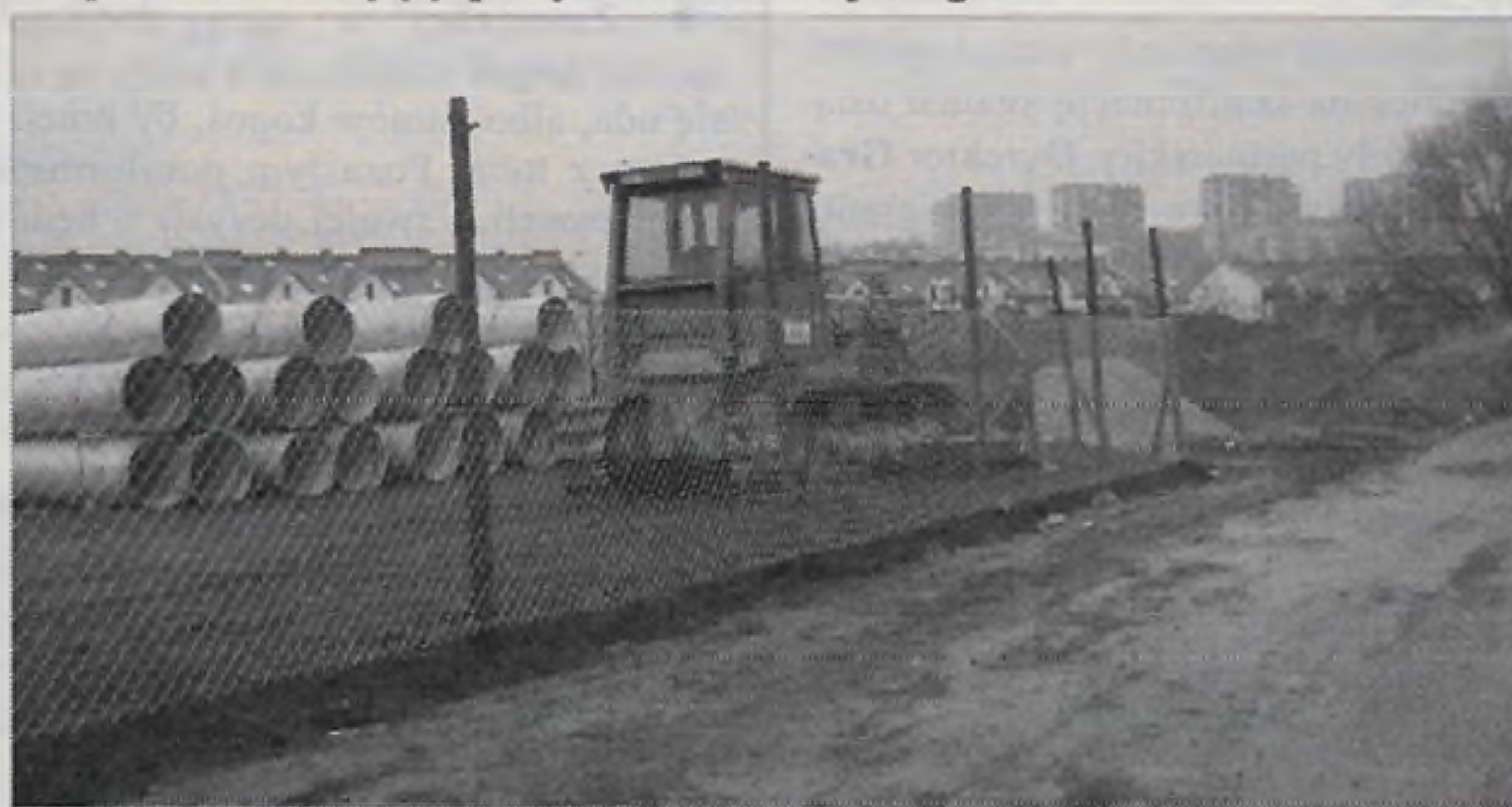
Rury pod przyszłą kanalizację opadową.
