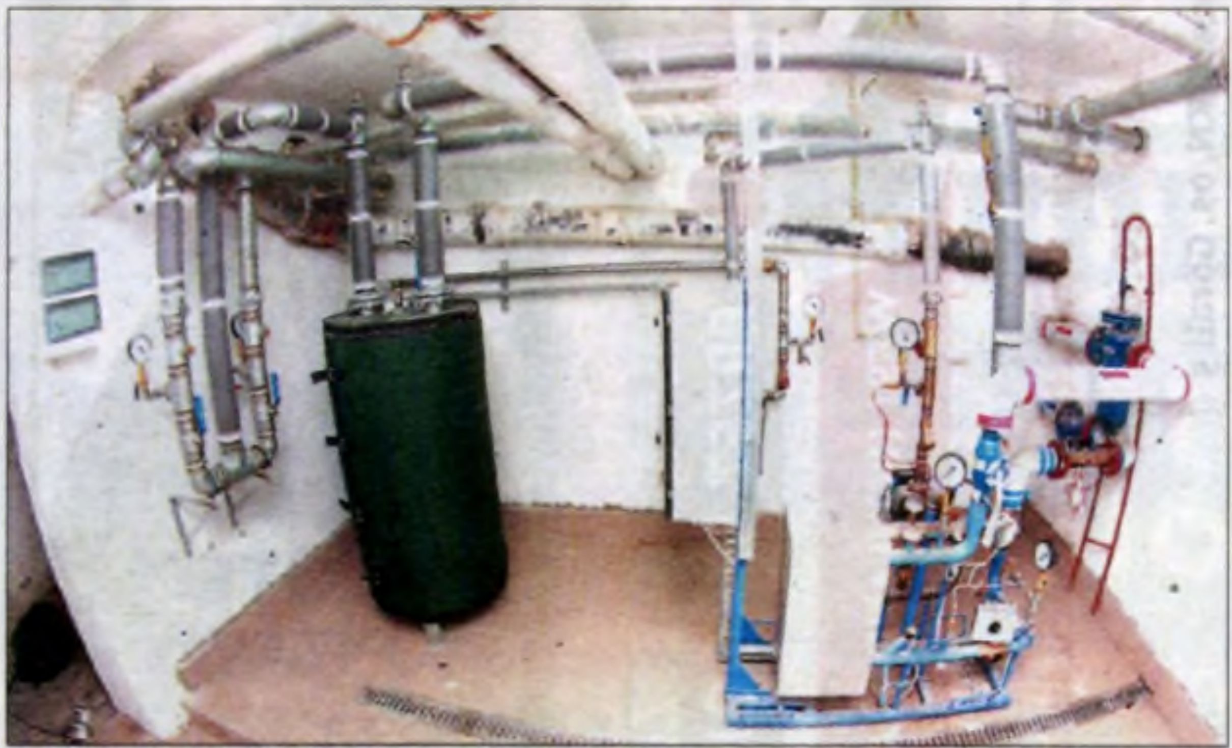
Wymiennikownia z węzłem cieplnym.
