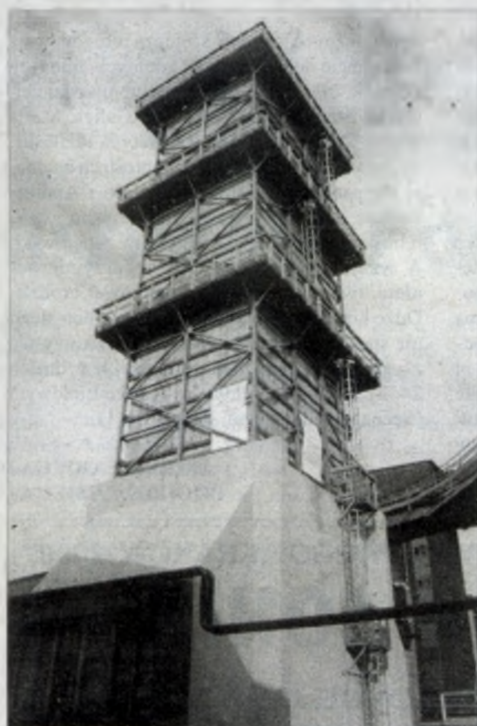
Nowa wieża – zamiast ceglanej – konstrukcja z metalowej kratownicy i impregnowanego drewna.
