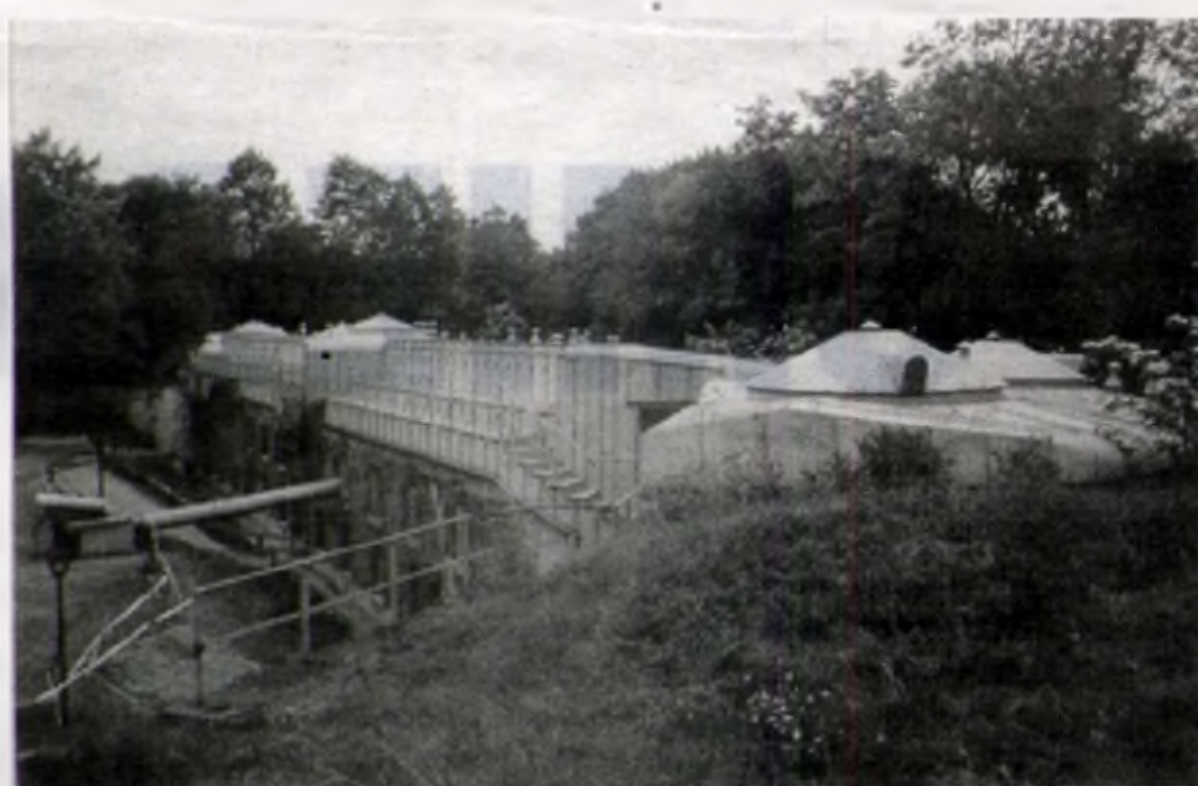
„Mały fort” Grębałów – 49 1/4 wybudowany w latach 1896–1898. Dach i galeria strzelecka nie są oryginalne, ale zostały odnowione według starych projektów. Wzdłuż całego fortu, biegła galeria strzelecka. Na tych schodkach, za osłonami stalowymi stali strzelcy z karabinami. Dzisiaj w Grębałowskim forcie mieści się klub jeździecki.
