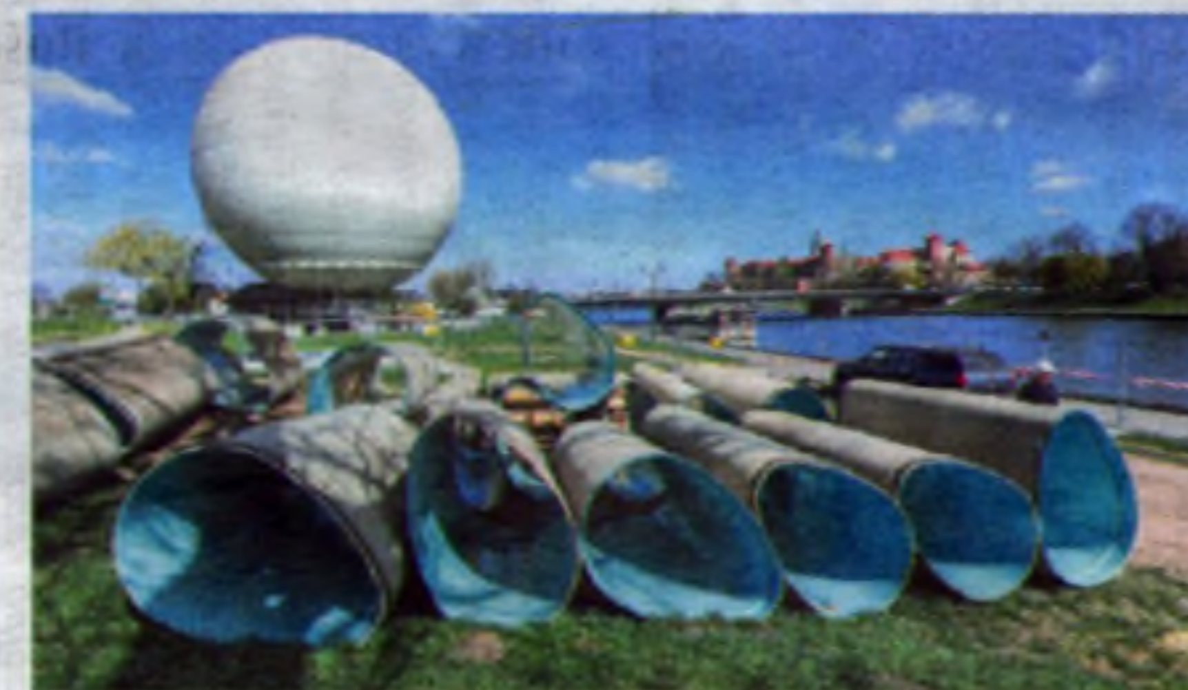
Renowacja panelami GRP prawobrzeżnego kolektora Wisły
