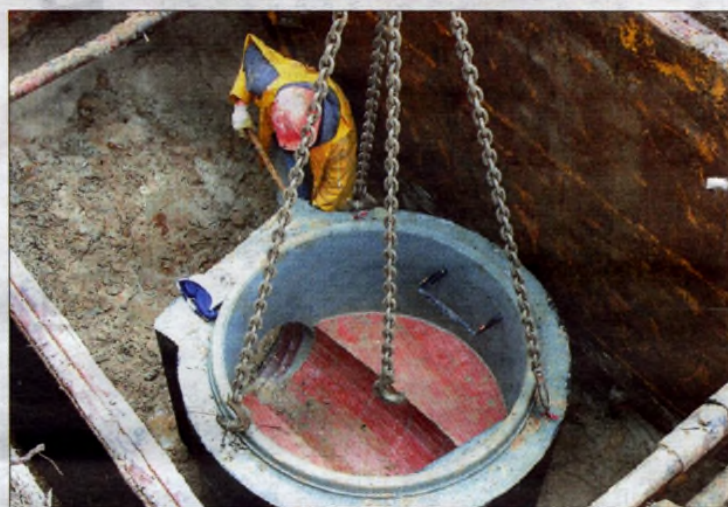
Montaż studni kanalizacyjnej w ul. Tokarzewskiego.
