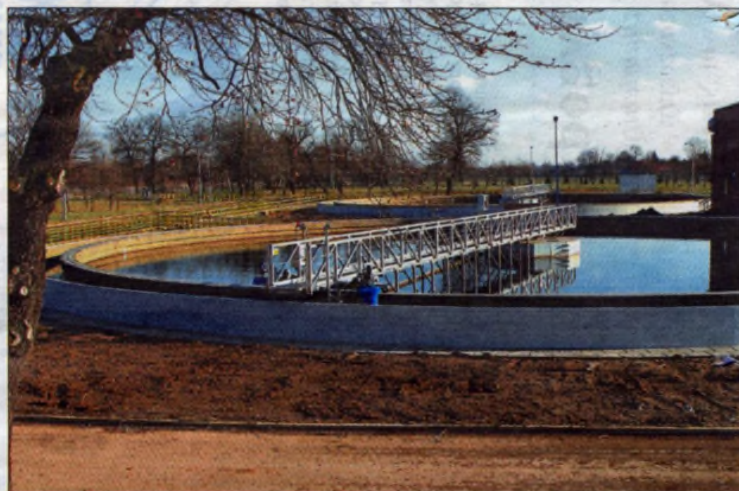
Osadnik wtórny – Oczyszczalnia Ścieków Kujawy.
