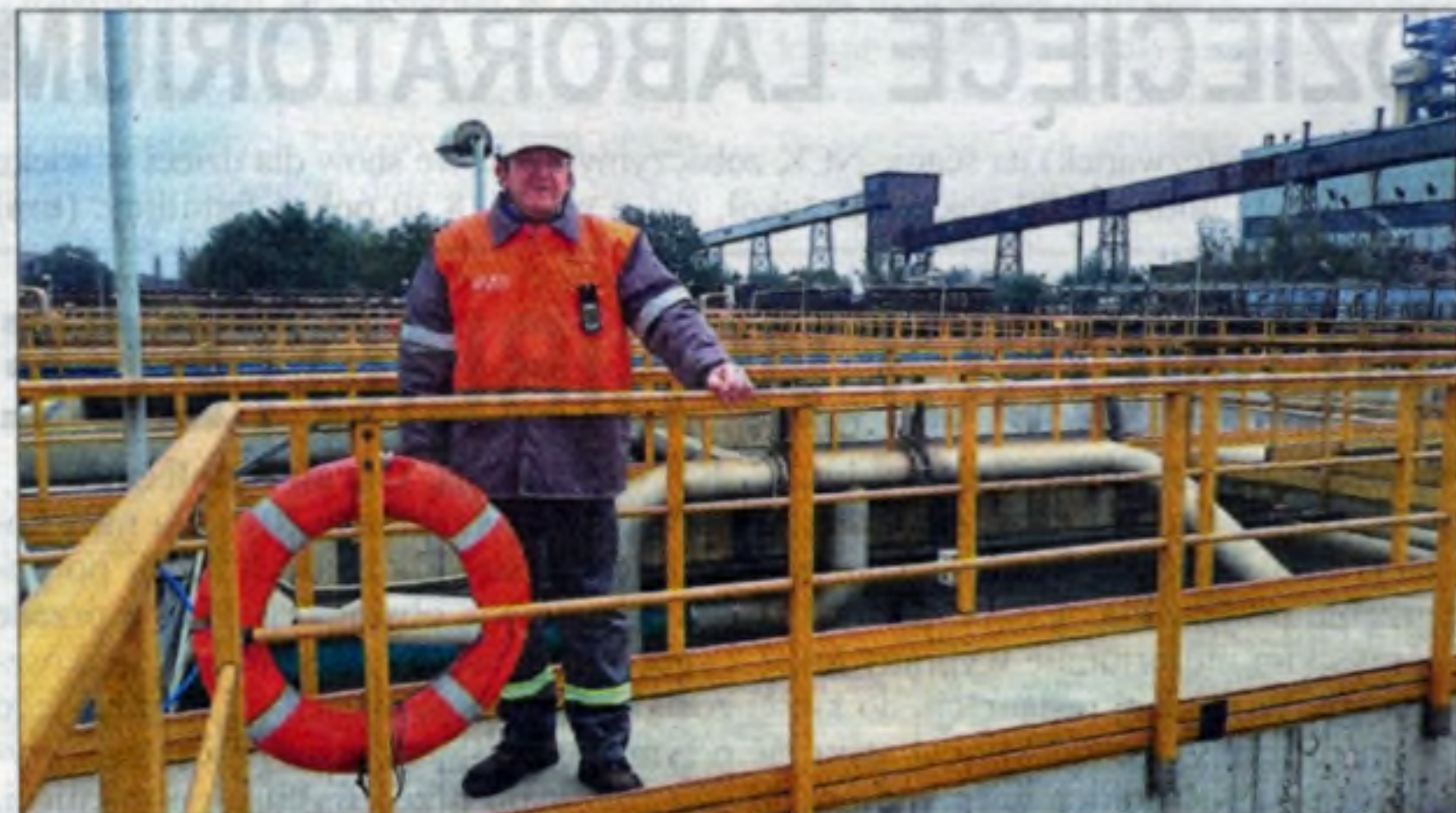
4 wykonane z żelbetu baseny o głębokości 6 metrów, wysoki na 15 metrów zbiornik na tlen. Oczyszczalnia biologiczna koksowni ma do oczyszczenia 300 tys. metrów sześciennych wody poprocesowej na rok – mówi Piotr Warzecha. Stąd oczyszczona woda trafia do miejskiego kolektora, a następnie do oczyszczalni ścieków Kujawy.
