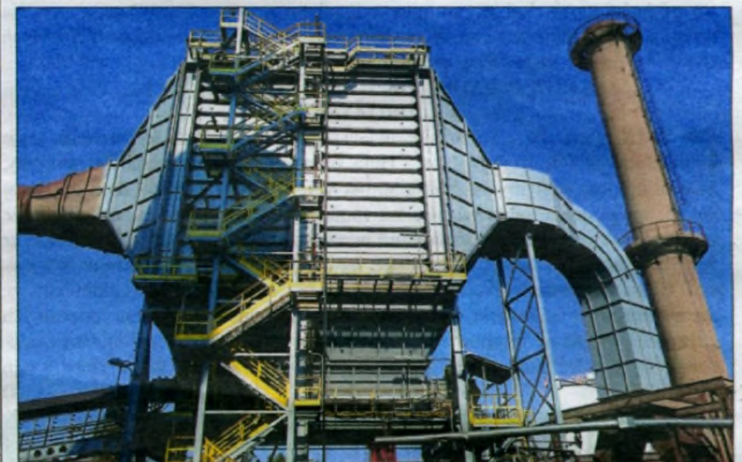
Ten elektrofiltr zapewnia dobre warunki pracy na hali lejniczej podczas spustu.
