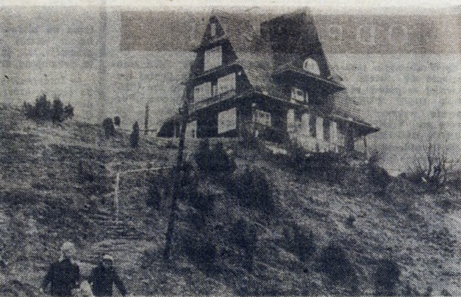
Piękny obiekt w Sromowcach ulega dewastacji.
