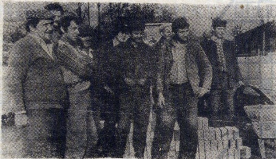
Budowniczo-techniczne basenu w Rabie Niżnej, ośmioosobowa brygada pod „dowództwem” kierownika budowy — Józefa Żywieckiego — wykonała na najwyższym wyróżnieniu. Wykonali olbrzymi zakres robót. Bez ich sumiennej i rzetelnej pracy, planowane oddanie basenu do użytku w czerwcu przyszłego roku nie byłoby po prostu możliwe.
