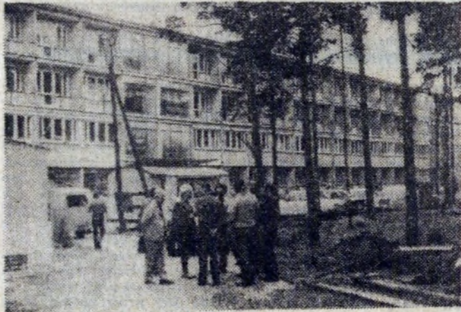
Ośrodek wypoczynkowy Stoczni „Gryfia” w budowie...
