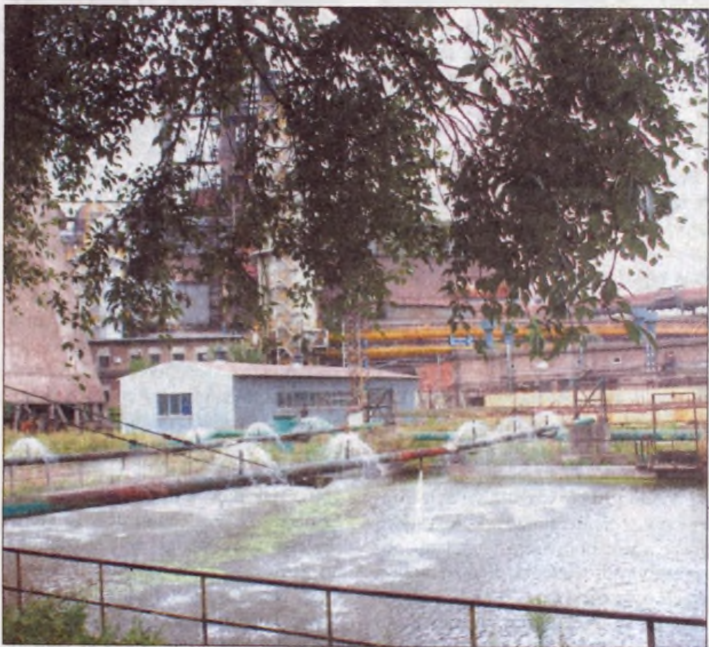
Wielka chłodnia kominowa i spryskiwacze schładzają wodę z obiegu chłodzącego wielkiego pieca.
