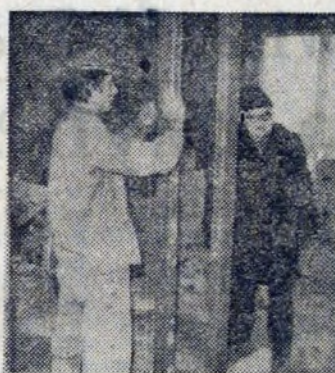
Tak się zakłada futryny wewnątrz budynku, tym razem metalowe.
